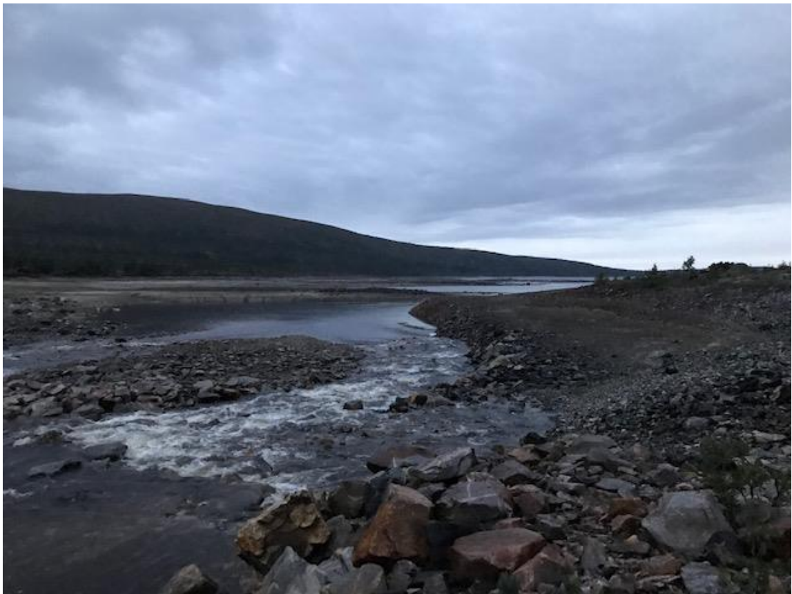
Tunnelutløpet i sørenden (vannet fra Hukla og Kusma) 27. aug. 2018 – 481,60 m
