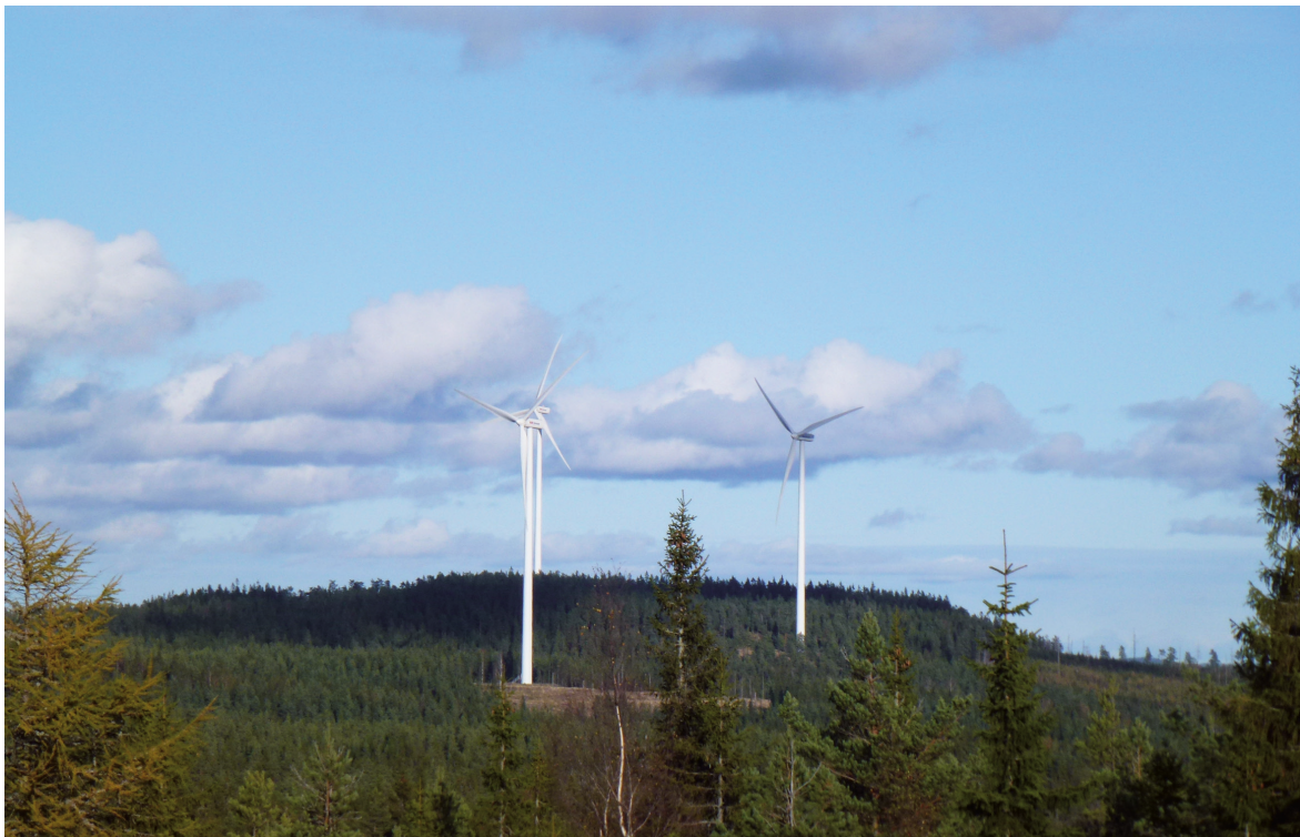
Figur 6. Eksempel på vindturbiner som kan være egnet for vindkraftprosjektene i Birkenes kommune. Tårnet i aktuelle vindturbiner er cirka 90-120 meter høyt og hvert vingebled er cirka 40-60 meter langt. Fotoet viser turbiner i Fjällberget vindkraftverk, Ludvika i Sverige. Foto: Sweco.
