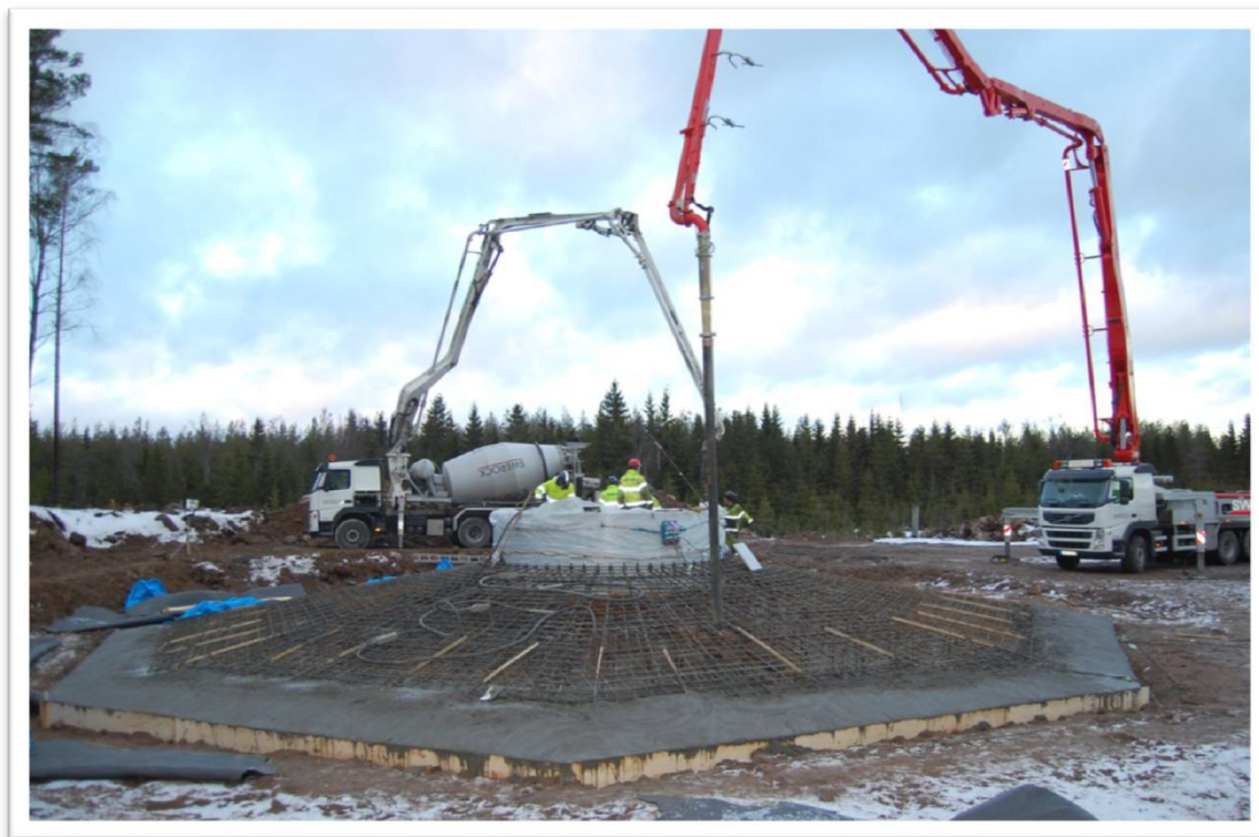
Figur 6-17: Støping av gravitasjonsfundament. Foto E.ON Vind
