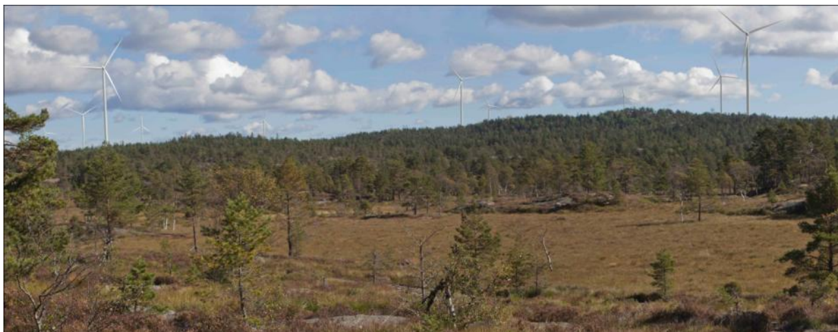
Figur 5-17 Standpunktet viser deler av Storhei vindkraftverk fra planområdet. Standpunktet viser hvordan vindkraftverket vil være synbart fra en rekke standpunkter i det åpne lendet. Standpunktet er representativt for flere tilsvarende områder preget av åpne myrer, åpen furuskog, rabber og berg i dagen. Fotomontasjen viser også størrelsesforholdet mellom turbiner og eksisterende kraftledning. En av mastene bryter så vidt horisontlinjen til venstre for den bakerste av de to turbinene i montasjens høyre billedkant.
