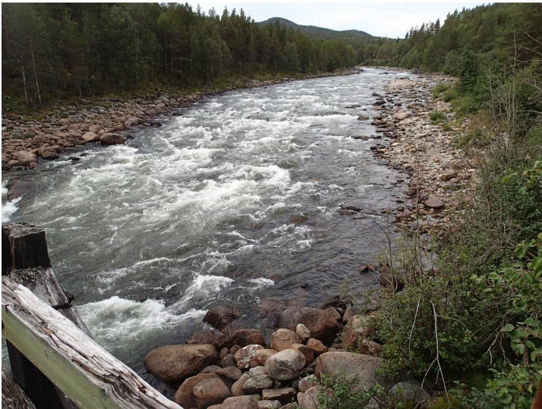
Figur 2: Øvre del av prosjektområdet. Den planlagte terskelen blir plassert ca. 30 meter oppstrøms denne brua. Sideløp og inntak til kanal blir til høyre i bildet.
