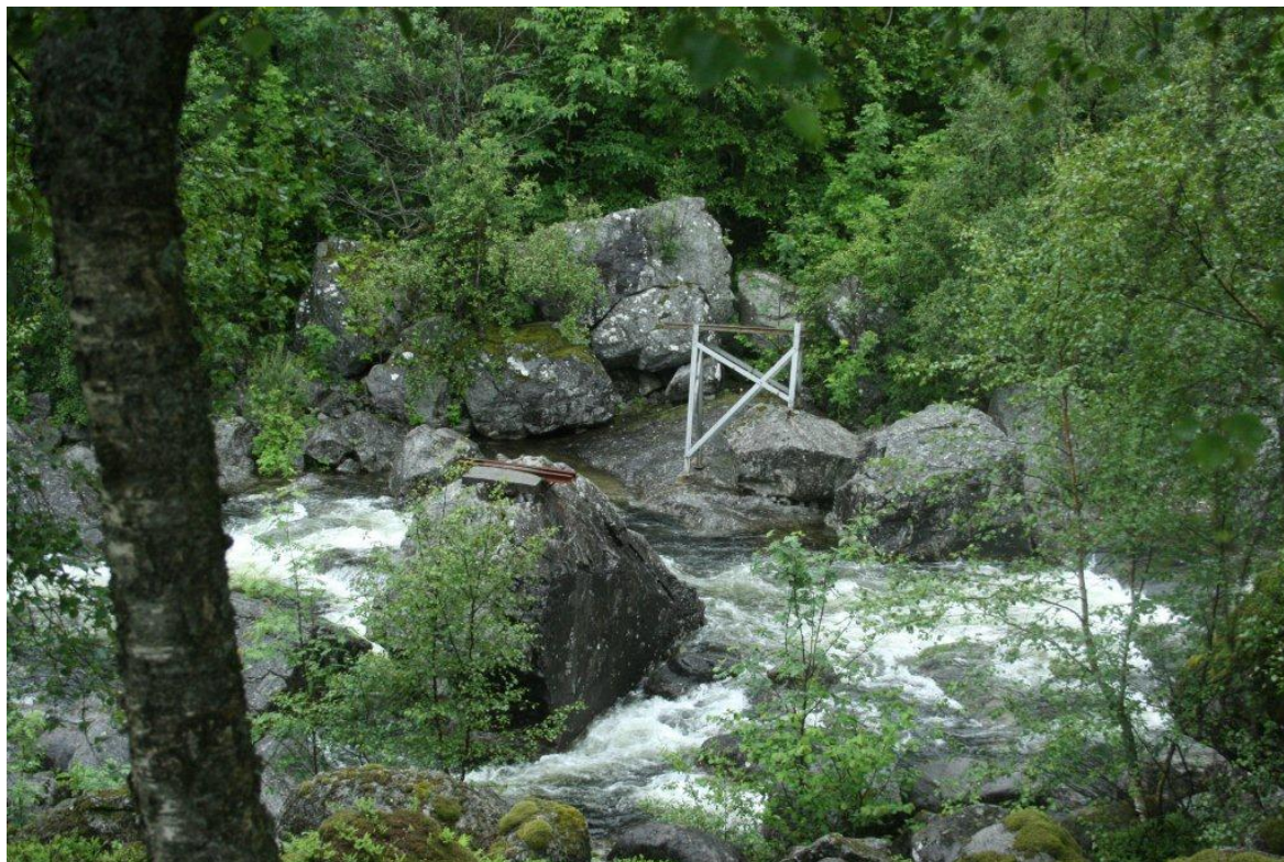
Bilde 8.3 Rester av gammel gangbro
