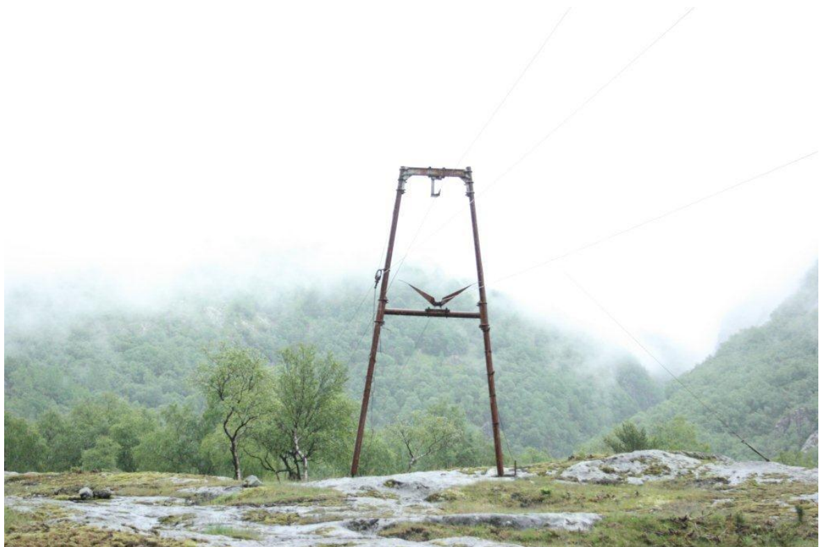
Bilde 8.2 Kabelbane opp til Åse
