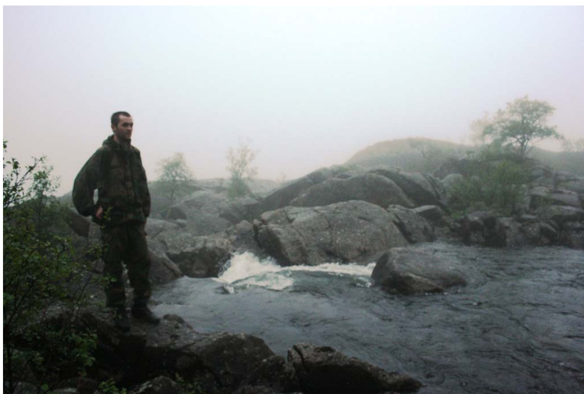
Bilde 2.2 Dam i fa en terskel støpt til fjell
