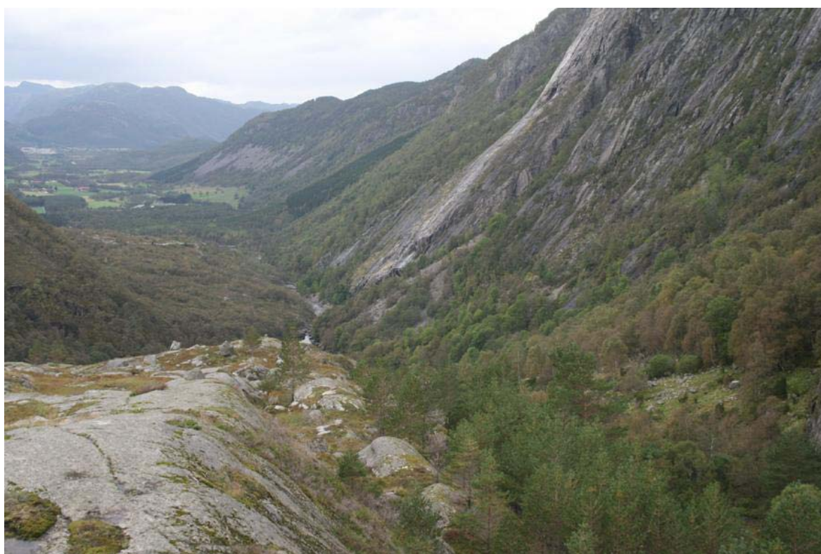
Bilde 4.2 Vannveien i fjell videre på høyre side til kraftstasjonen
