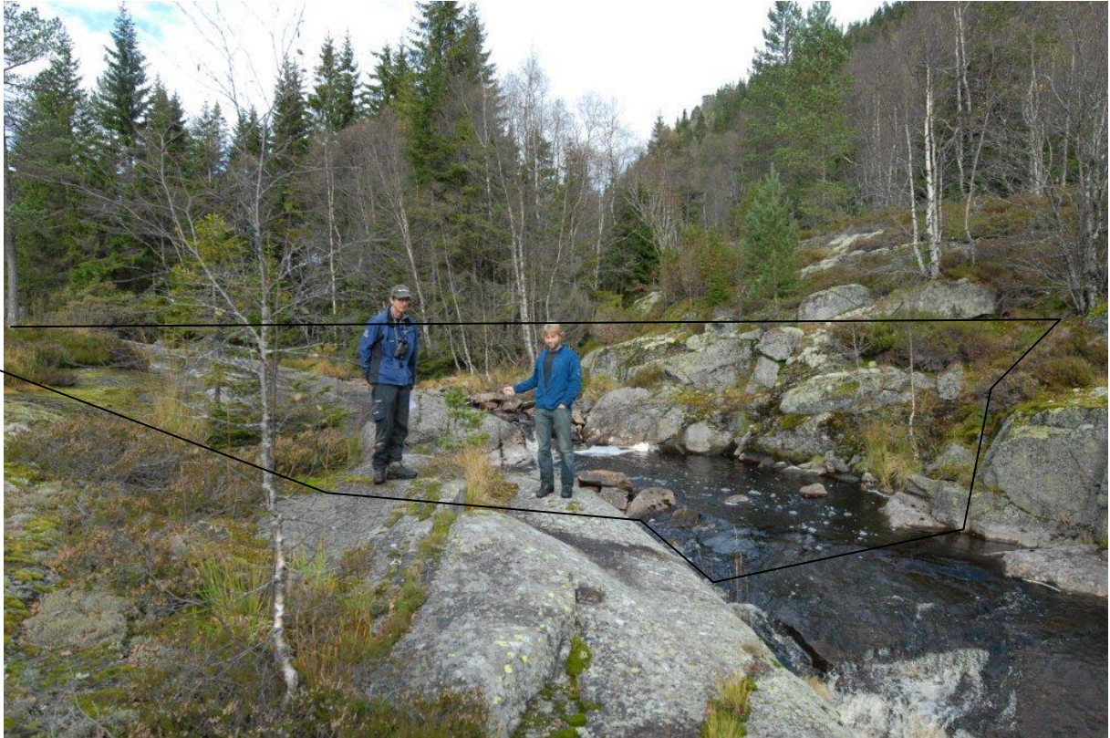
Dam Losmentmyra: Sett fra nedstrømside Dam med inntak er skissert i bilde.
