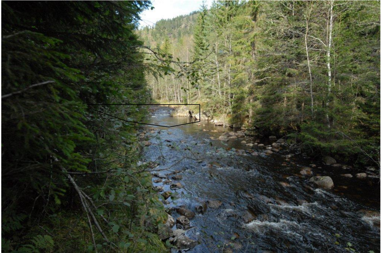
Dam Korsseter: Sett fra nedstrømsside Dam med inntak er skissert i bilde. Rørgate vil ligge på venstre side.
