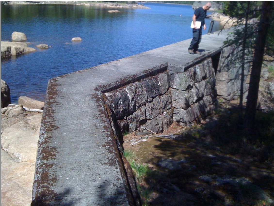
Dam stengestad: Bilde viser eksisterende damanlegg ved Stengestad inntak og rørgate er planlagt i fra eksisterende luke. Regulering av magasinet tilsvarende eksisterende regulering.
