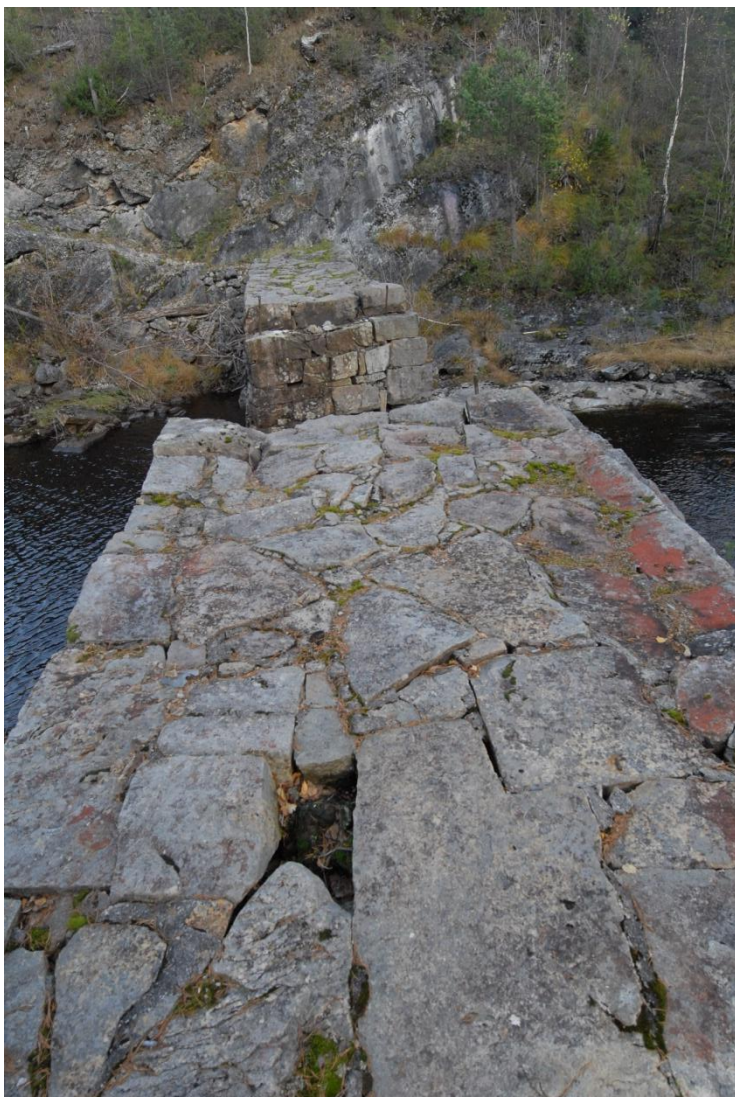
Den gamle håndmurte steindammen i utløpet av Nedre Blæsa. Denne dammen skal brukes slik den er i kraftprosjektet Holt med inntak i Nedre Blæsa, og blir et kulturminne i bruk.
