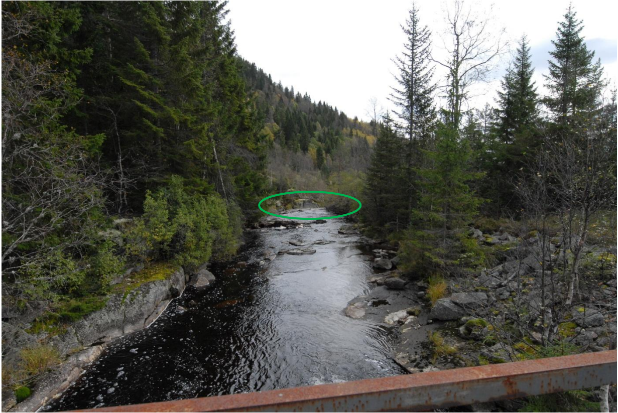
Elva sett fra bilbrua ned mot inntaket til Losmentmyra kraftstasjon.
