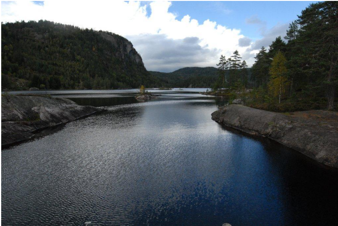
Bilde viser eksisterende inntaks magasin Valseter Kraftverk Gardvatn. Maggasinet er ca 1m nedtappet.
