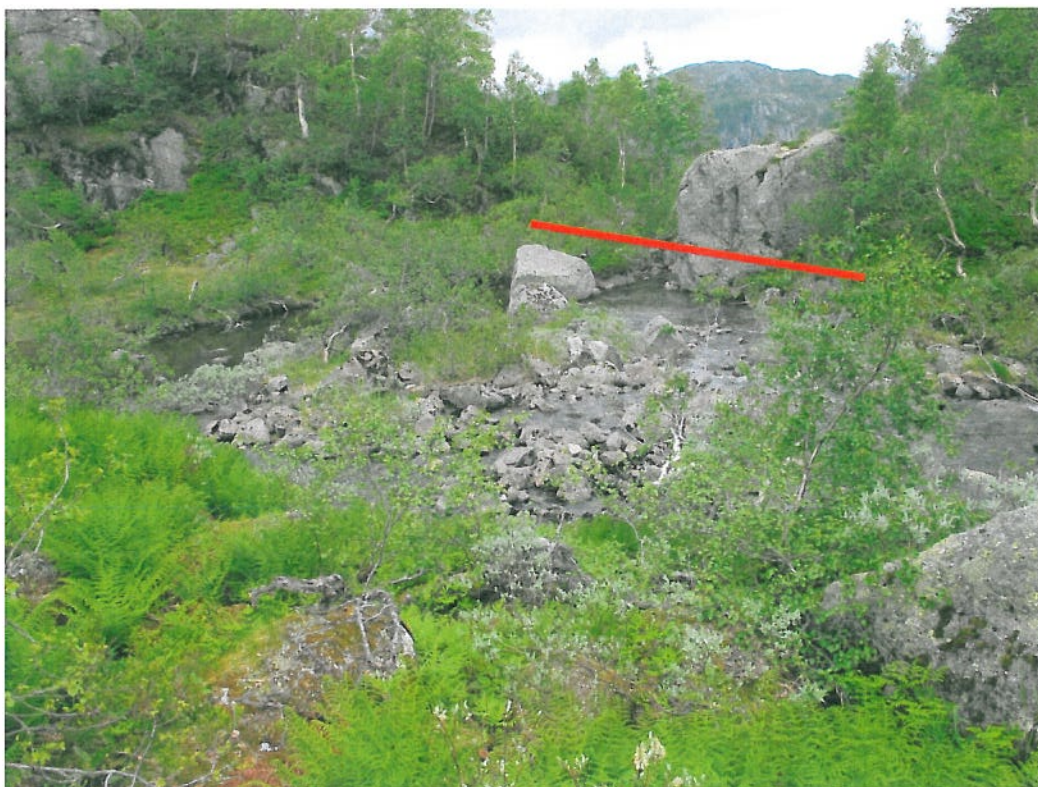
Figur 2-18 Inntak Tysdalseva kote 710 sett fra vest. Omtrent plassering av dam markert med rød strek.
