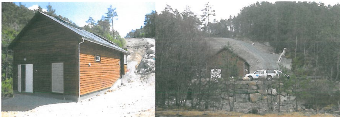
Figur 2-26 Eksempel på kraftstasjon
