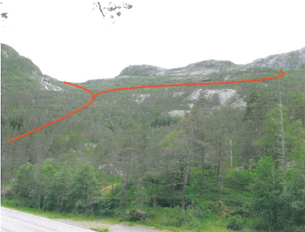
Figur 2-24 Rørtrase sett fra dalen
