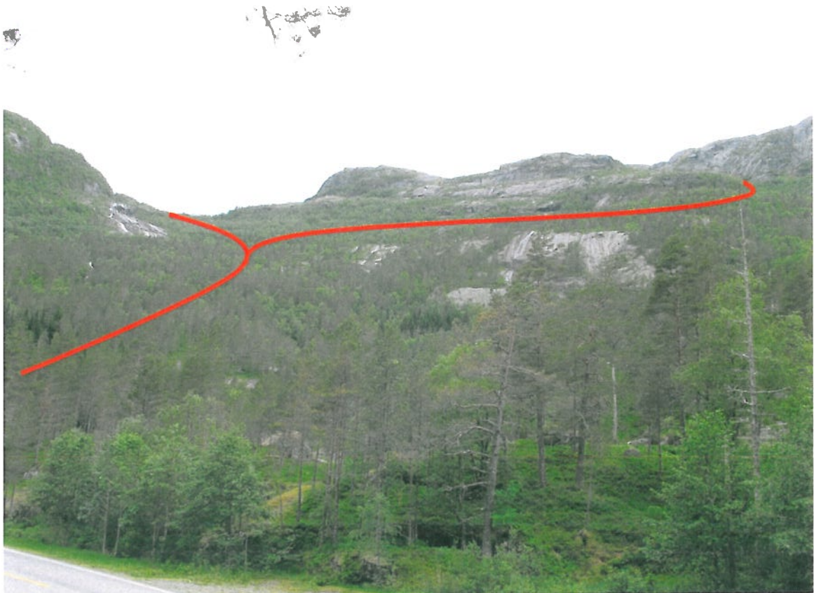
Tiltaksområdet sett fra dalen, med planlagt rørtrase inntegnet som rød strek
