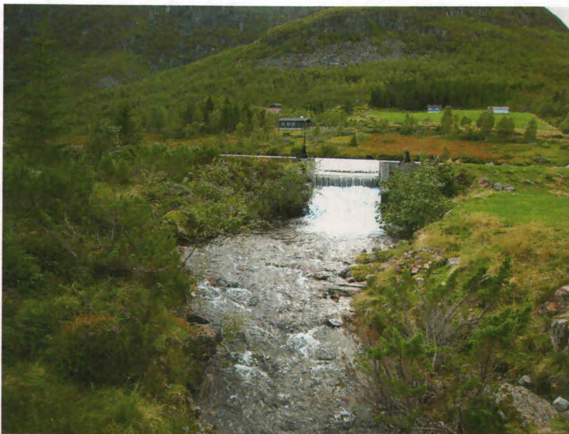
Utløp dam Dyrkornvatn
