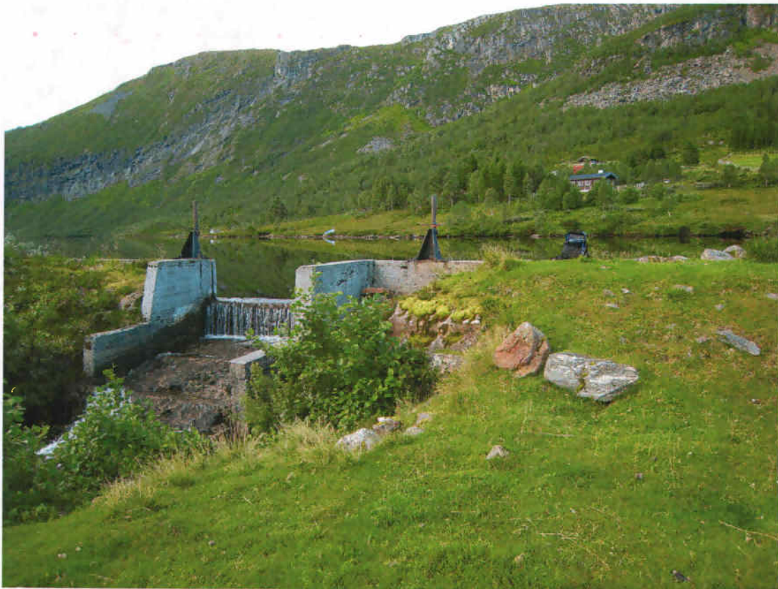
Dam Dyrkornvatn - overløp
