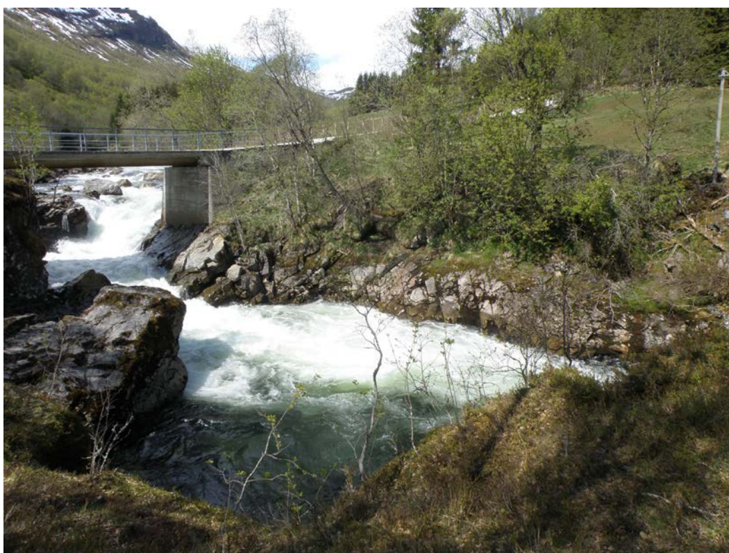
Figur 3. Middels til stor vassføring. Ved driftsbru i øvre del av råka strekning (øverst) og ved bru for kommunal veg (nederst)
