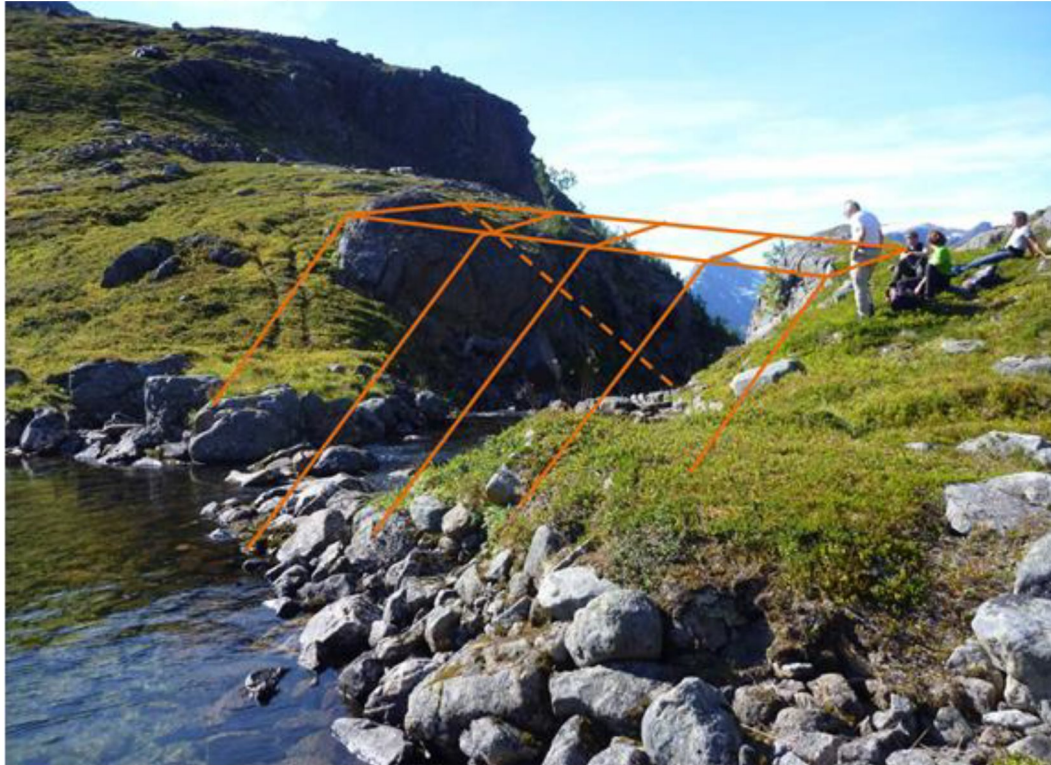
Bilde 3: Damsted v/utløpet i Hamnavatnet. Høyde på damkrone indikert.
