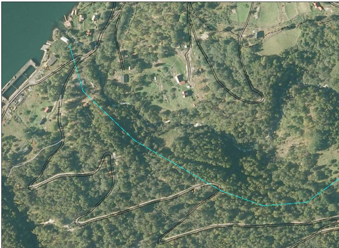
Fig. 44. Nedre del av rørtrasé/vannvei går gjennom kulturpåvirket løvskog og nær ved bygdeveien i dalen.
