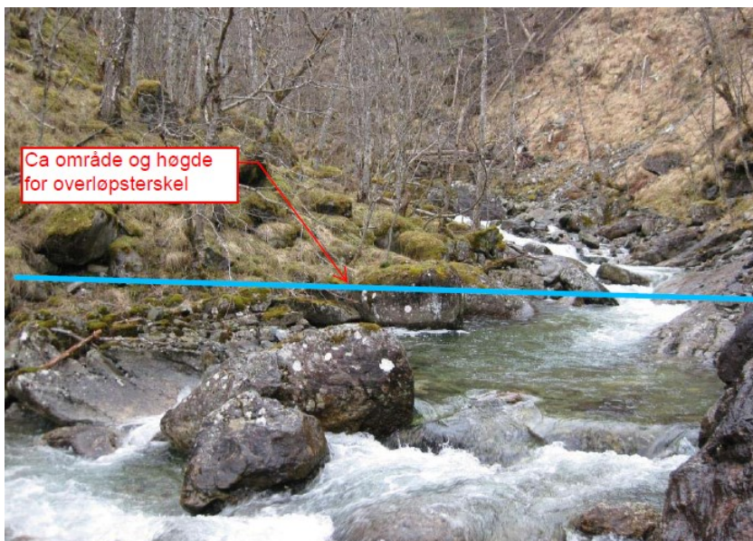
Inntaksområde, kote 207. Foto: 26.03.2012. Vassføring er berekna til 0,7 m 3
