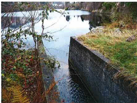
Eksisterende utløpskanal med bredde 1,4 meter
