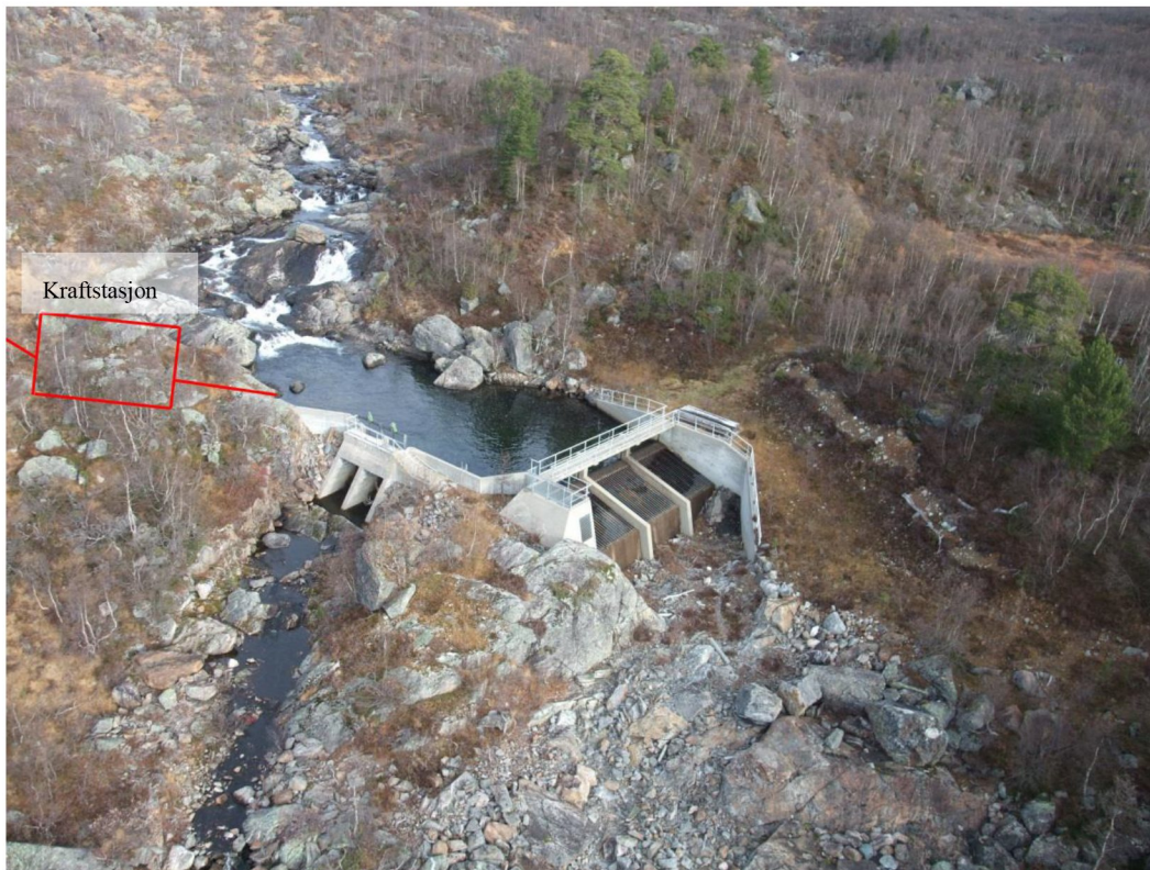
Eksisterende inntak overføringstunnel Lislevatn-Førsvatn. Veringsåe Kraftstasjon avmerket til høyre.
