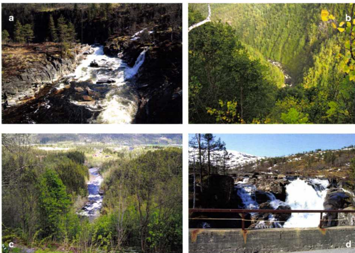
Figur 7 Vindøla a) ved inntak (sett fra brua), b) sett fra veien, c) nedstrøms kraftstasjonsområdet, d) oppstrøms inntak og bru.
