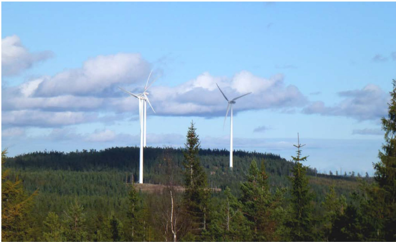
Figur 5. Eksempel på vindturbiner som kan være egnet for Bjørkebråtaberget vindkraftprosjekt. Tårnet i aktuelle vindturbiner er ca. 100-120 m høyt og hvert vingeblad er ca. 45-60 m langt. Fotoet viser turbiner i Fjällbäret vindkraftverk, Ludvika i Sverige. Foto: Sweco.
