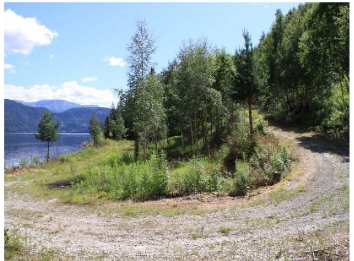
Bilde 40 – Adkomstvei ned til kraftstasjon fra Tinnsjøveien F37
