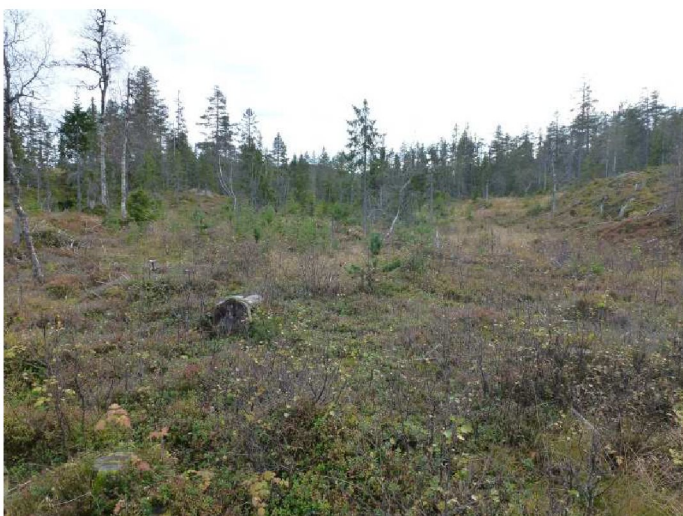
Bilde 29 – Trasé for tilløpsrør gjennom snauhogst, ca kote 565
