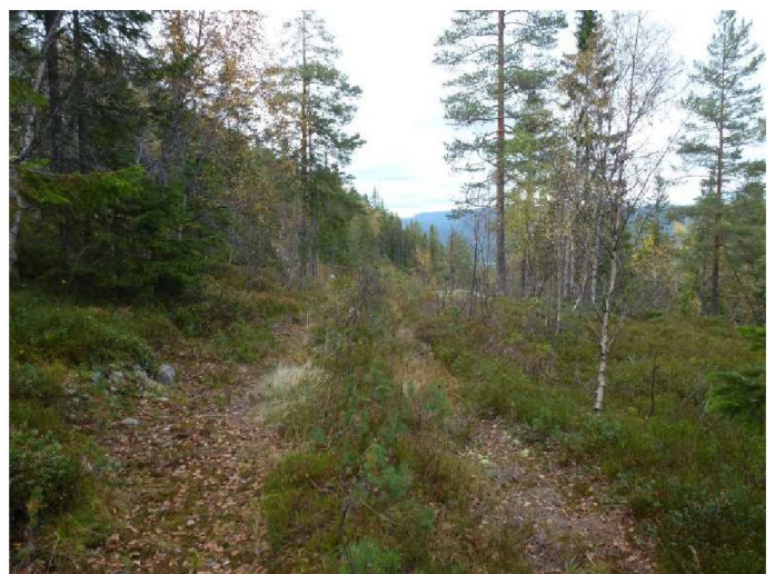
Bilde 30 – Trasé for tilløpsrør langs eksisterende skogsvei, ca kote 525
