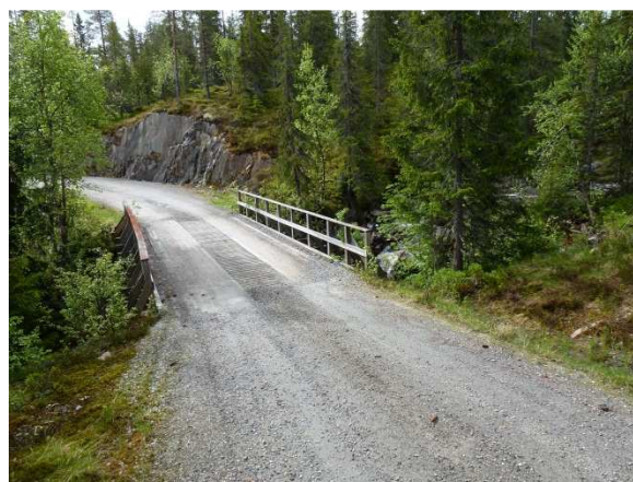
Bilde 04 – Bru over Raunebekk ca kote 665
