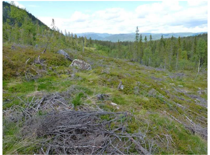
Bilde 26 – Trasé for tilløpsrør gjennom snauhogst, ca kote 620
