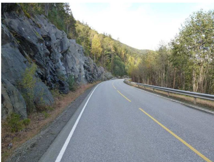
Bilde 41 – Tinnsjøveien F37 over planlagt kraftstasjon
