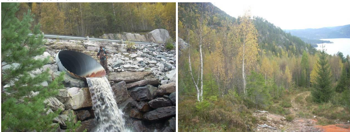
Figur 7: Bergåa i rør under Fv 37 (venstre) og traktorvei gjennom ungskog langs midtre del av planlagte rørgate (høyre). Fotos: Ole Roer.
