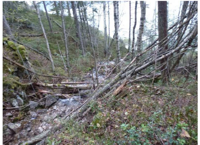
Bilde 20 – Rørtrasé langs bekk fra Timmerkastet ned mot kraftstasjon, ca kote 225
