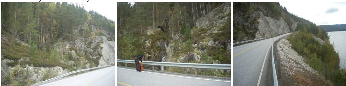
Planlagt stasjonstomt sett fra Fv 37 (venstre), samt utløp under fylkesveien ut i Tinnsjøen langs mindre eksisterende bekk.
