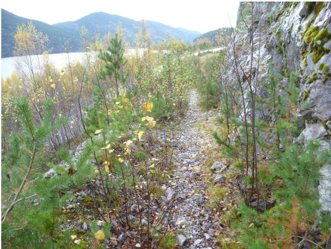
Figur 11. Del av traktorvei som begynner å bli overgrodd. Fylkesvei 37 kan sees i bakgrunn. Tatt mot SØ.
