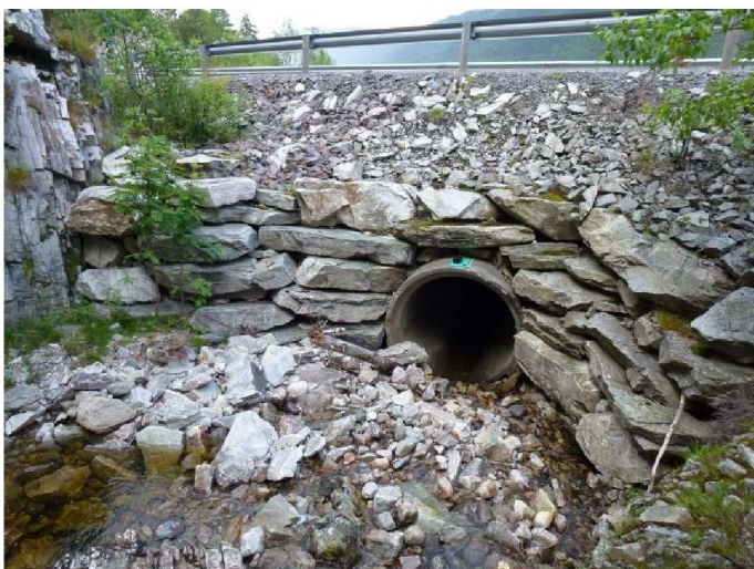
Bilde 23 – Bekk fra Timmerkastet renner i rør under FV37 Tinnsjøveien
