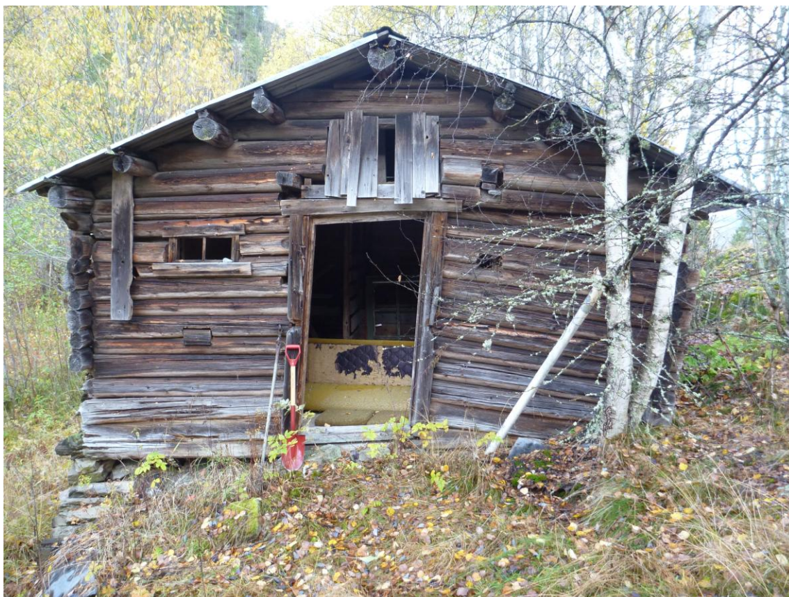
Figur 18. Det minste bygget på Timmerkastet. Tatt mot NNV.
