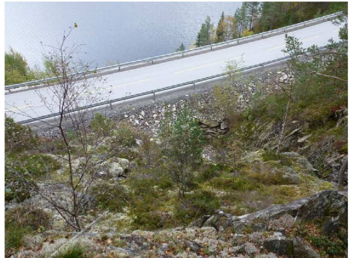
Bilde 22 – FV37 Tinnsjøveien sett fra kraftstasjonsområde
