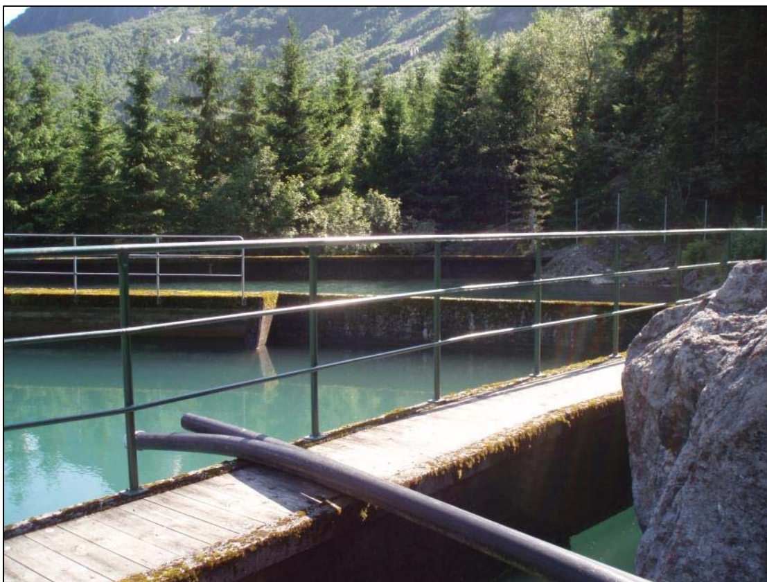
Bildet viser eksisterende Tokheimsdam, ved plassering stasjon K1
