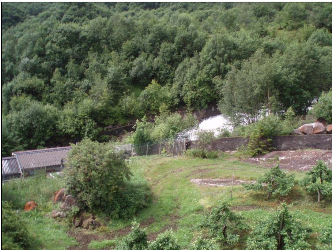
Bilder viser område for plassering av kraftstasjon K2, kote 40 moh
