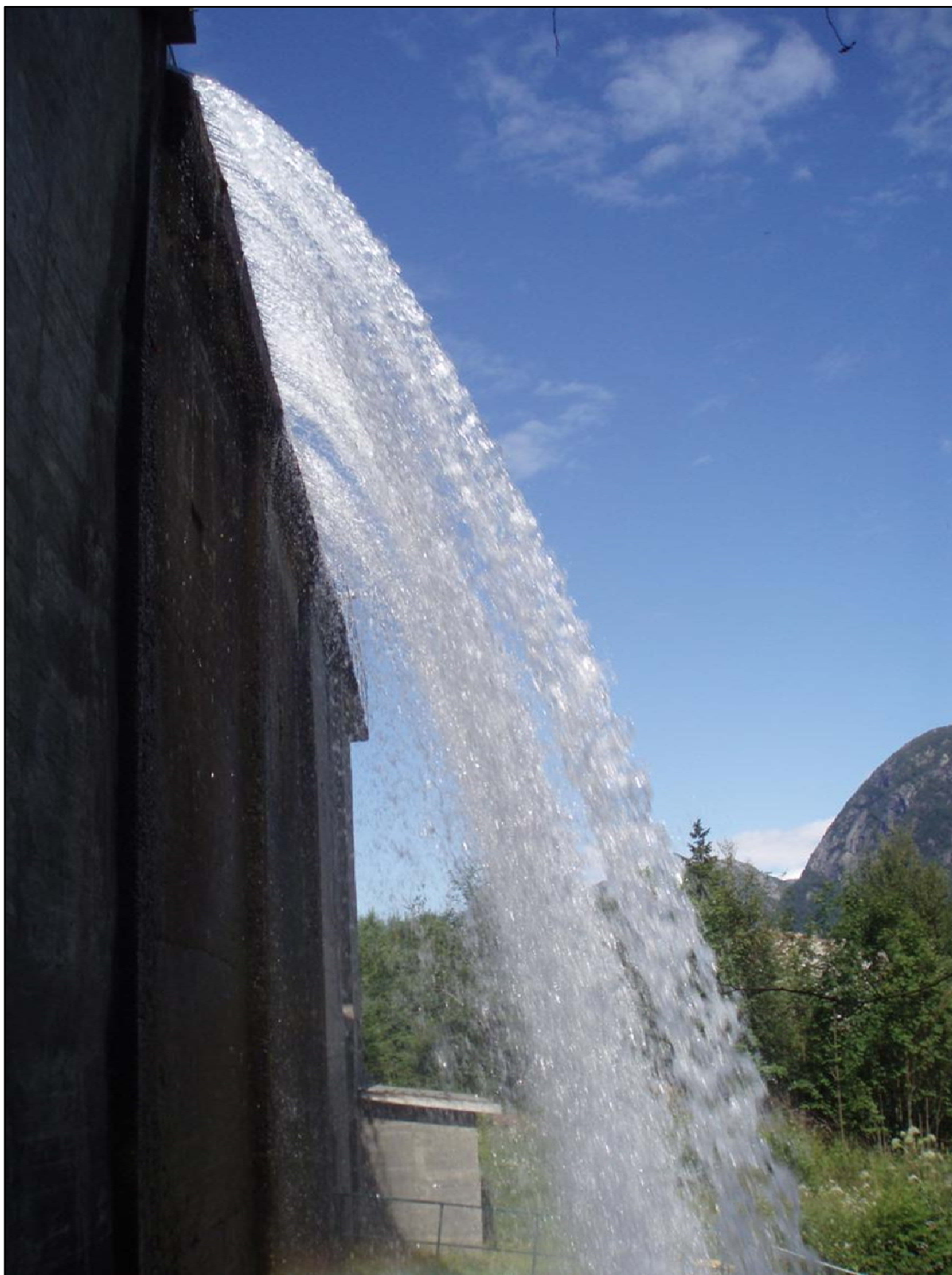
Bilder viser overløp over Tokheimsdammen, kote 135
