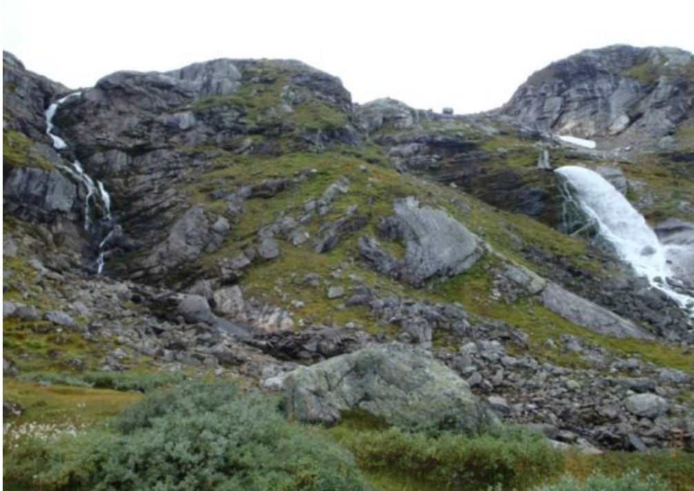
Øverste elveløp fra overløp samt utløp fra tunnel. Bilde tatt fra sletta.
