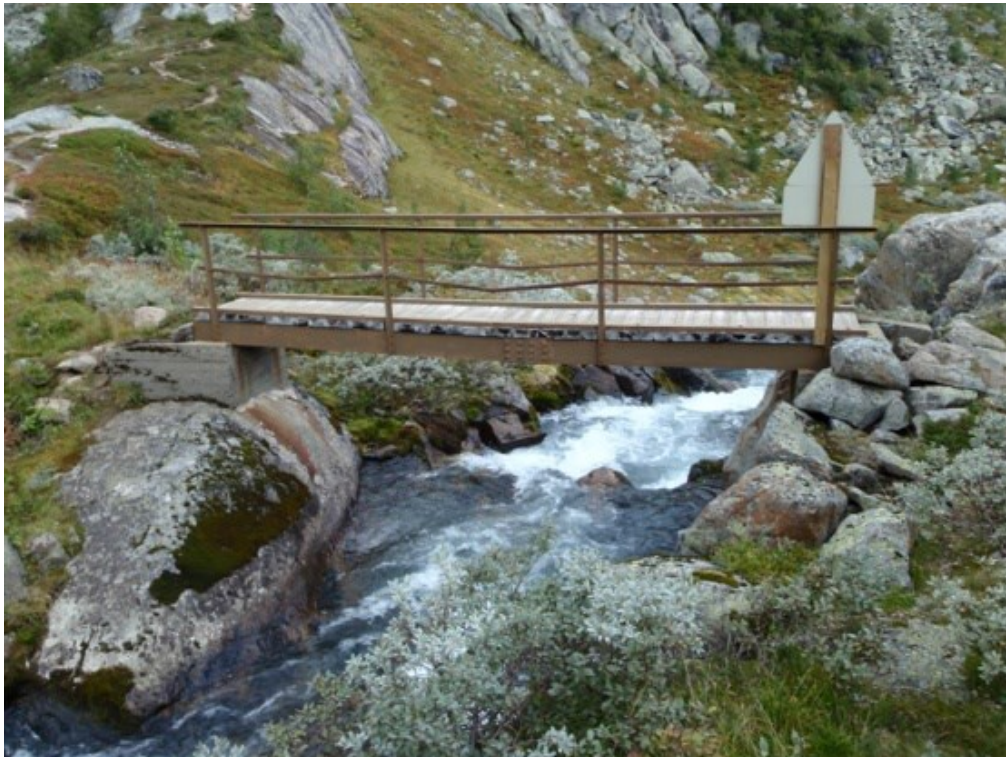
Bru, bruåpning ca H = 2,3 B = 5 m.
