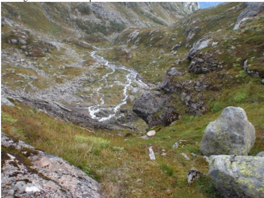
Terreng nedenfor overløpet. Bekkedal fra dammen ned mot første slette hvor vann fra tunnelen og overløp dam møtes. Bilde tatt nedenfor fot av dam.
