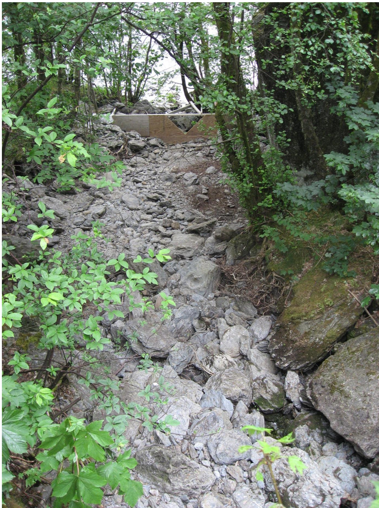
Utbyggjar sin målestasjon ved utlapet til Døldå.
