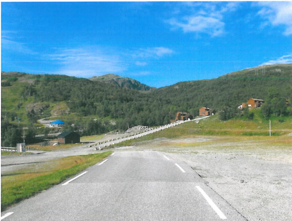
Oversiktsbilde over nedre del av tiltaksområdet ved Sauda skisenter
