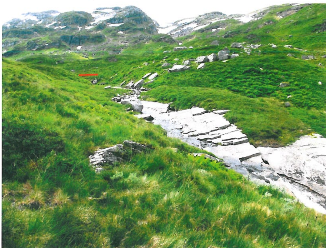
Figur 14 Bekkeinntak og område nedstrøms inntak
