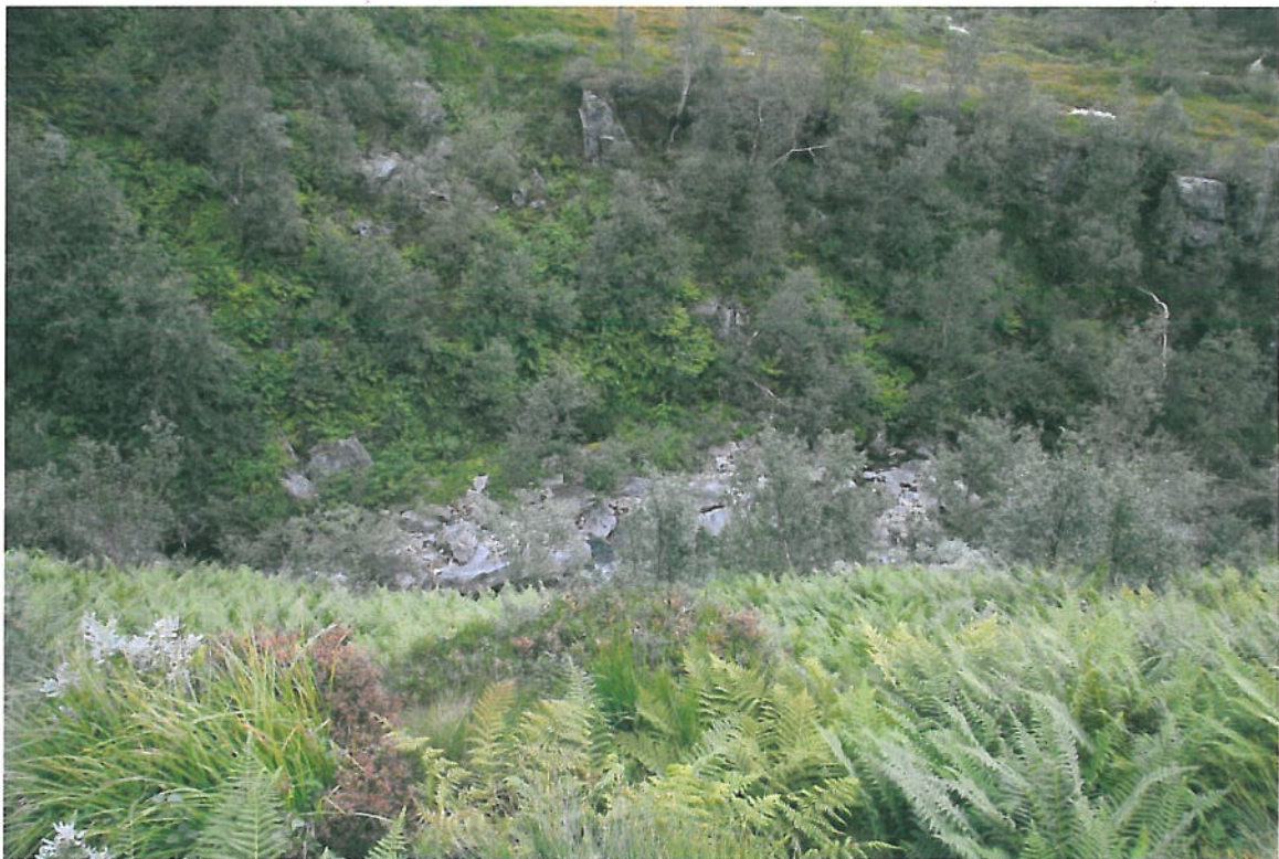
Ved inntaksområdet, Svandalselva
