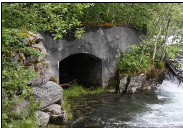
Figur 25. A/B: Den ene av to laksetrapper i Kavlifoss er håndhogd i stein, og blant de eldste i landet. C/D: Reguleringskum og utløp av det gamle kraftanlegget i Kavlifoss. Foto: Ole Kristian Spikkeland.
