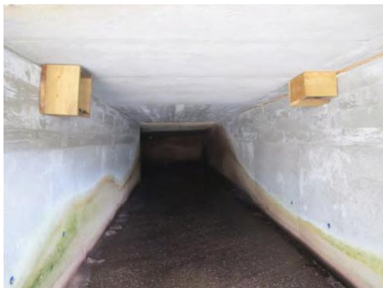
Figur 4.2 Fossefallkasser montert i kraftstasjonsutløp (Fossefall og småkraftverk: Bjørn Walseng, NINA Kurt Jerstad, Jerstad viltforvaltning).
