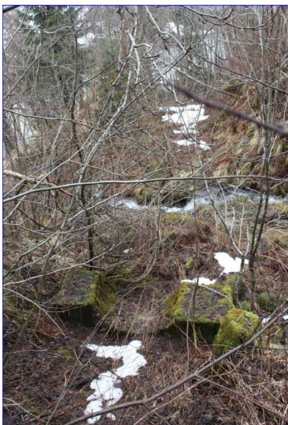
Figur 2.2.5.2 Foto viser gammelt rørfundament som fjernes og rørtrase som benyttes pånytt.
