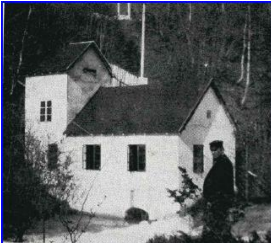
Gamle Kavlifoss kraftverk
