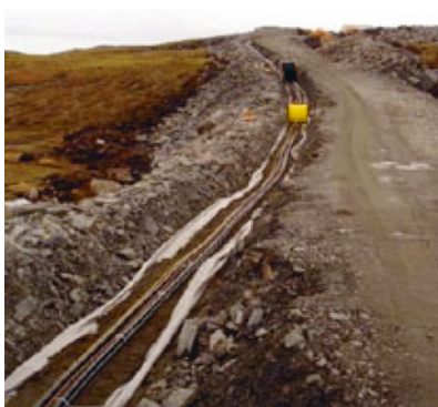
Figur 6 : 22 kV-kablene fra hver turbin graves ned i veiskulderen
