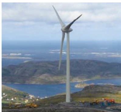
Figur 5 : Enercons 2,3 MW turbin installert på Bessakerfjellet
