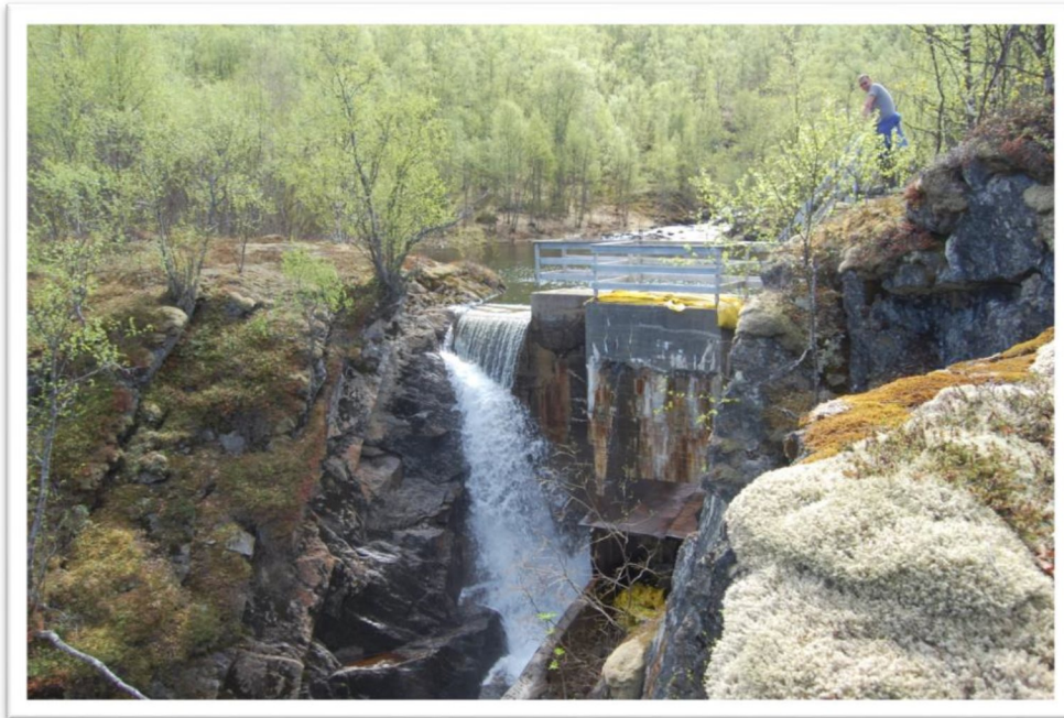
Bilde viser den gamle inntaksdammen til vannverket.
