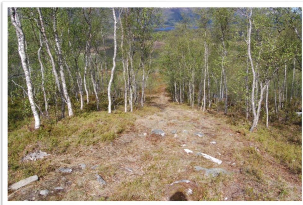
Bilde viser deler av traseen der røret vil bli liggende langs eksisterende skog/traktorvei.
