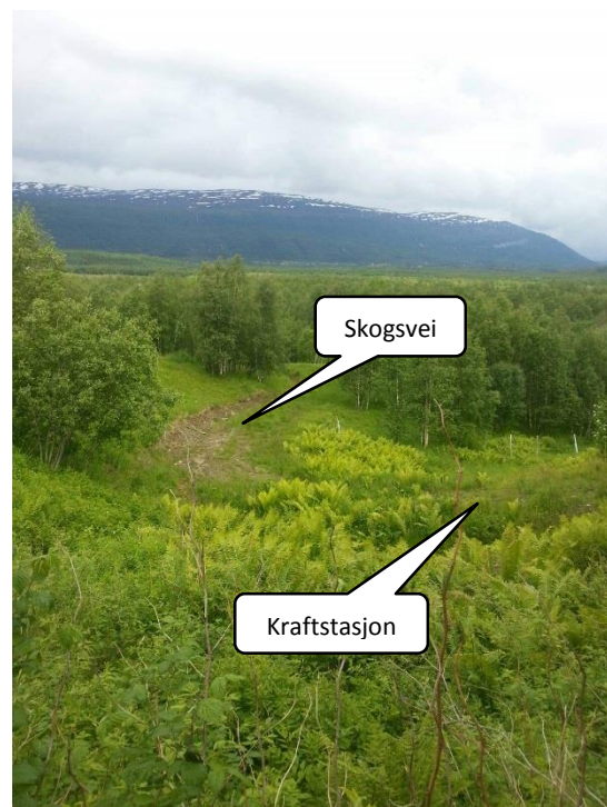
Skogsveien ved kraftstasjonen. Bredde ca. 3,4 m Foto: Bjørn Holtan
