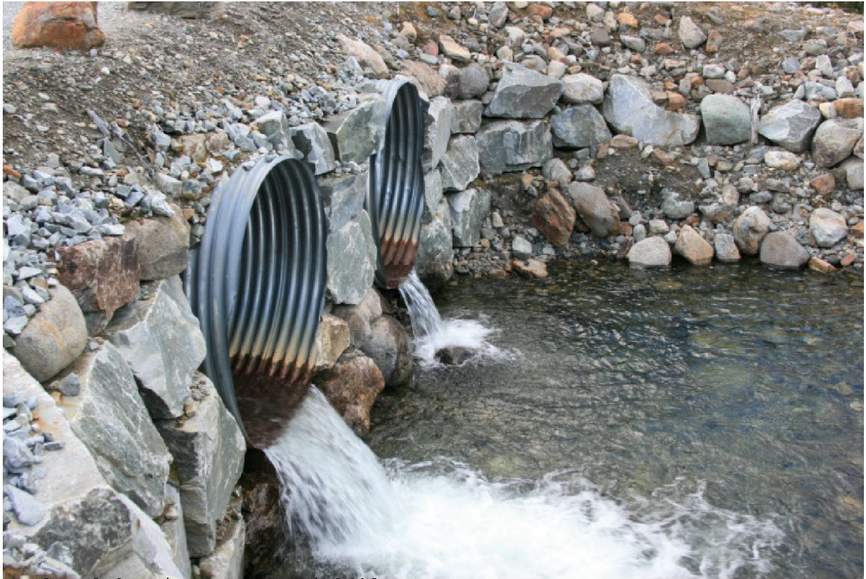
9. Elven ledes gjennom veiene, i doble rør.
