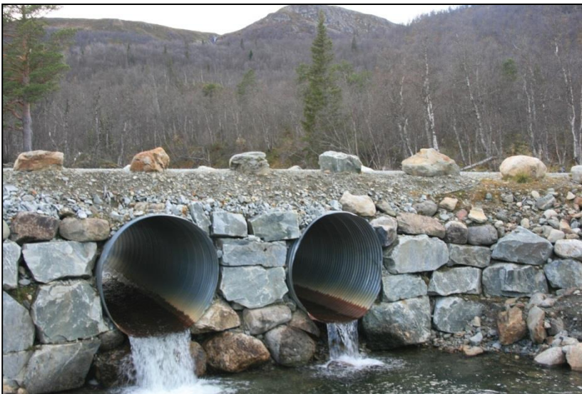
Figur 6. Gipa er lagt i rør gjennom veien, her oppstrøms den planlagte kraftstasjonstomten (ca. 200 m).
