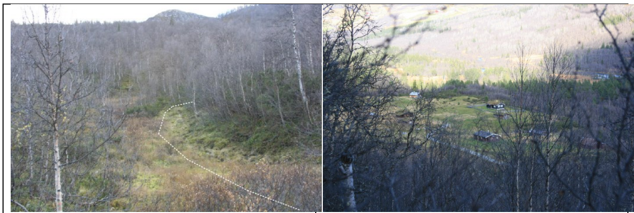
Figur 4: Rørgate og anleggsvei anlegges på nordsiden av Gipa (t.v). Fra rørgata er det utsyn mot Kjøsastølen og Rauddøla fra rørtraséen i dalsida nord for Gipa (t.h).
