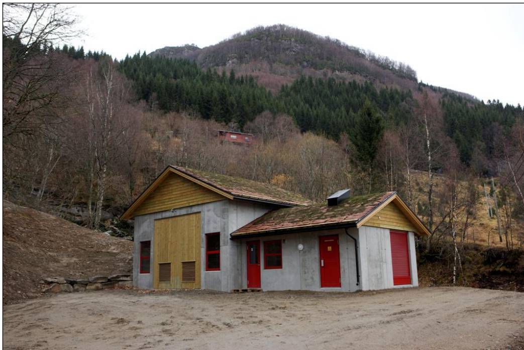
Figur 12: Typisk utforming av kraftstasjon
