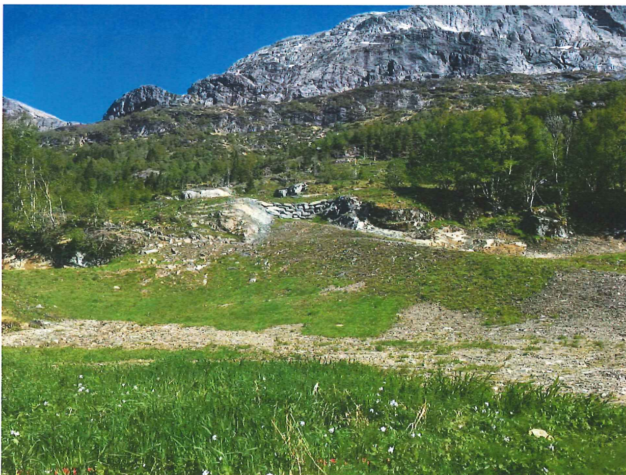
Figur 5: Etter inngrep, det er fylt opp masser til 2 meter frå topp eksisterande terreng og mura opp mellom fjellet på begge sider. Alternativt kunne muren vore trekt lenger fram og vorte jordslått dersom ein ville skjule fjellet heilt.
