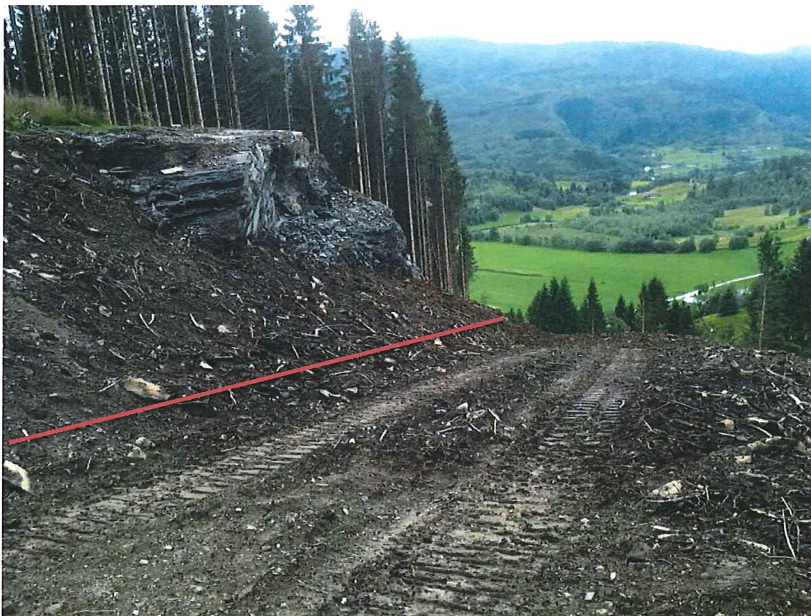
Figur 2: Arrondering av røytrase ved sidan av djup skjæring. Røytrase innteikna med raud strek innmed hammaren
