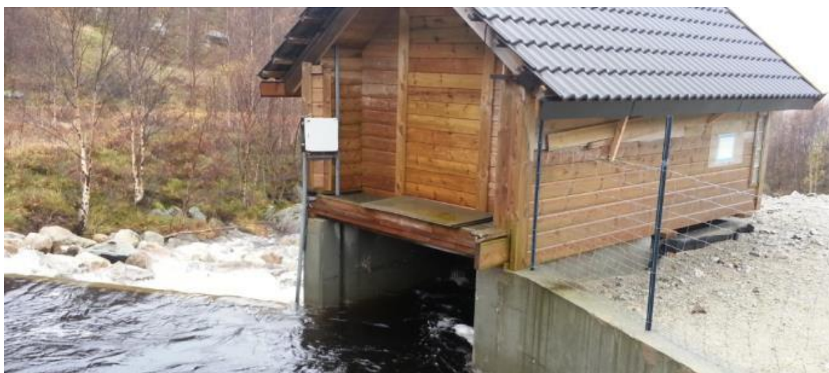
Foto fra inntaket i Fossbekken.
