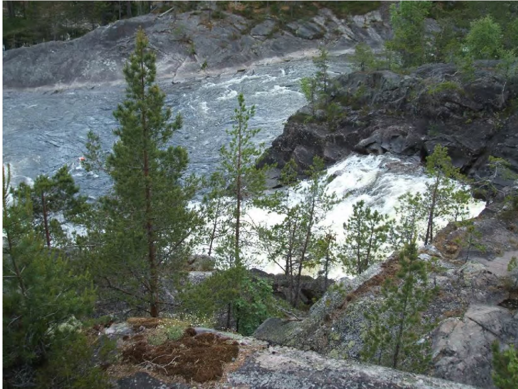
Figur 9 Herrefossen, østsida, trasé for tilløpskulvert nederst på bildet
