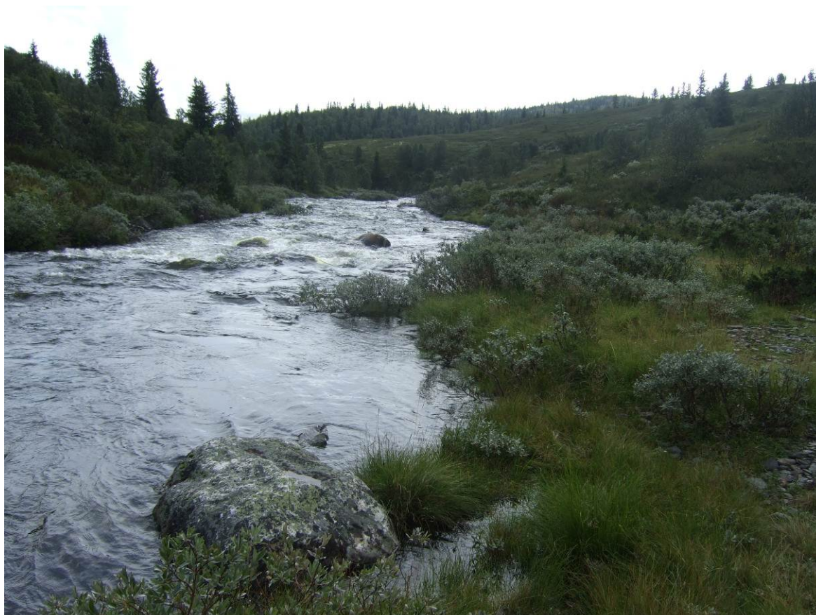
Bilde 2.2 Inntaksdam & nedover
