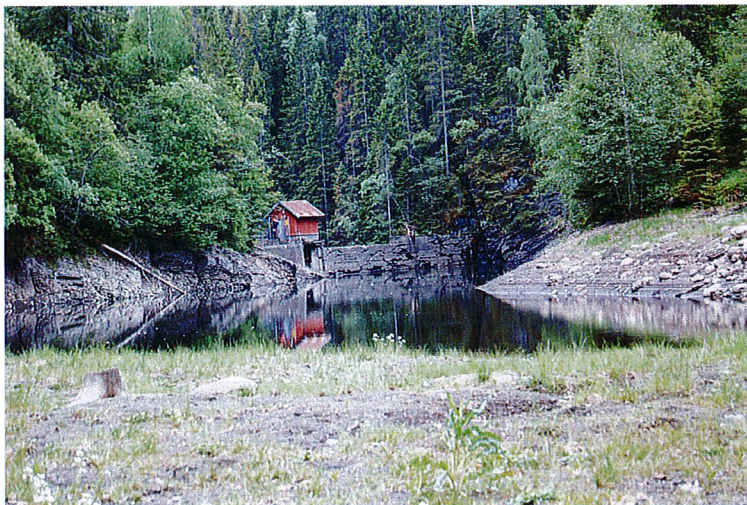
Bilde 1. Dammen sett oppstrøms fra 4. juni 2014
