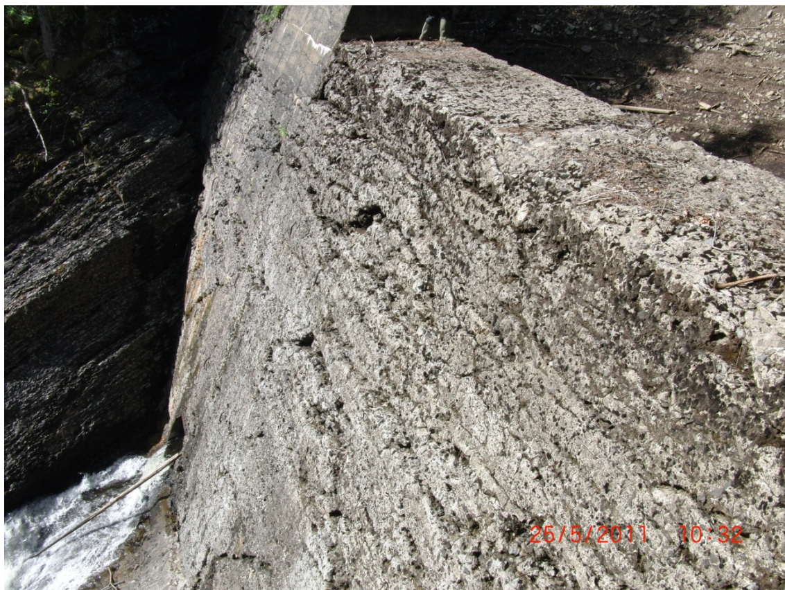
Bilde 7. Nedstrøms side av dammen
