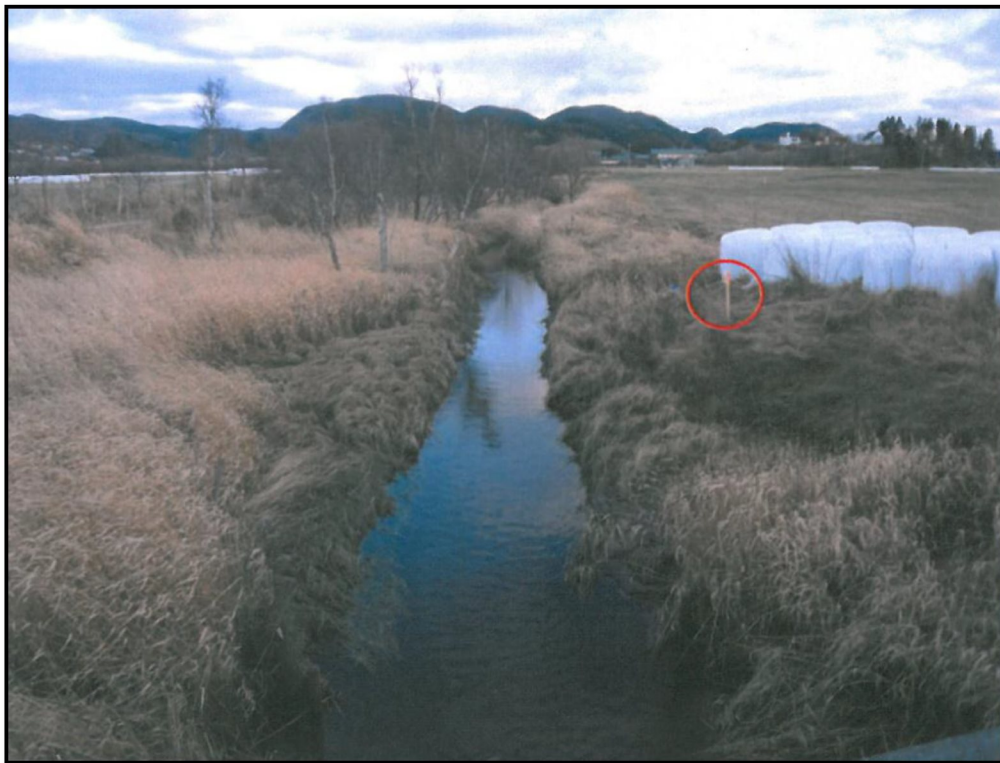
Figur 17 Bildet er tatt fra brua over Bodøelv og viser området som blir direkte berørt av veiutbyggingen. Ny RV80 vil krysse ca. der målepinnen er plassert (markert med rød ring).
