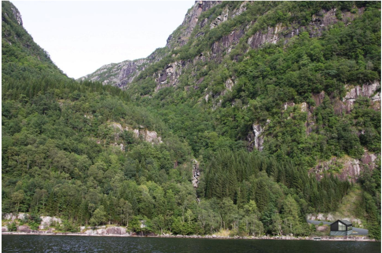
Bilde 1 (Fotoillustrasjon). Kastdalselvi (til venstre) og tilhørende kraftstasjonsplassering. Første del av vannveitrase (nedgravde rør) kan skimtes i bakkant av kraftstasjon. Fra tunnelpåhugg og til inntak vil vannveien ligge i fjell.
