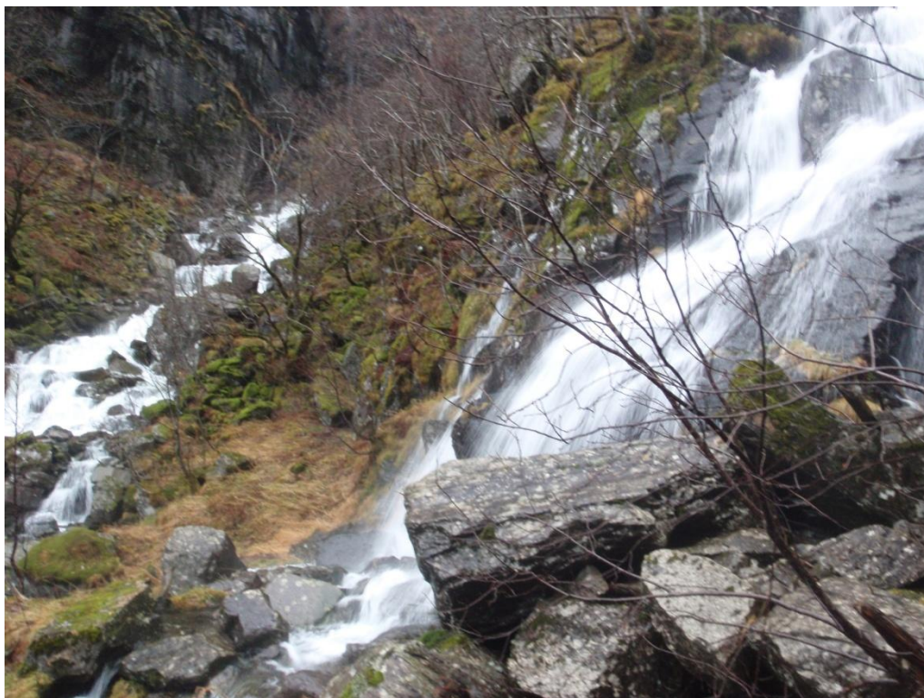
Ved inntaksområdet. Fjell i dagen i tillegg til steinblokker. Bekk fra sør i forkant av bildet.
