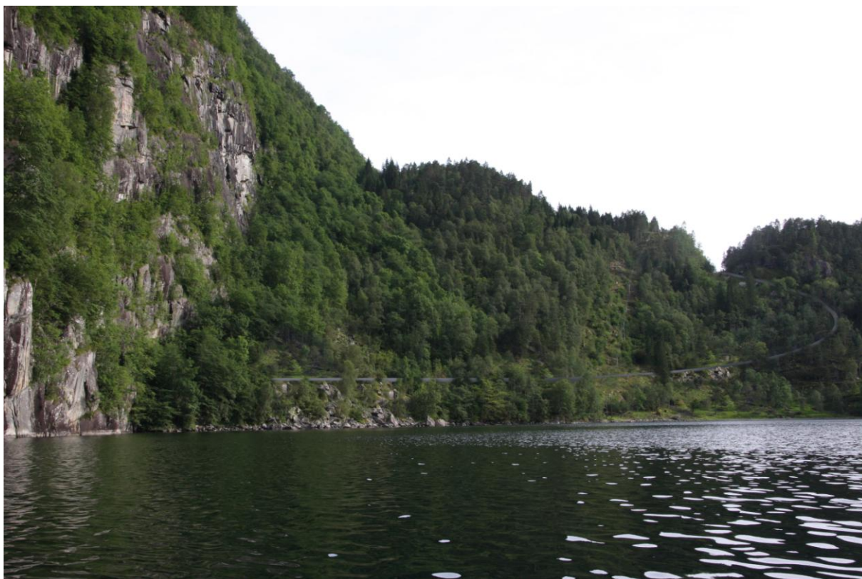
Bilde 4 (Fotoillustrasjon). Tilkomstvei og tunnel i prosjektområdet mot Furehaugen.
