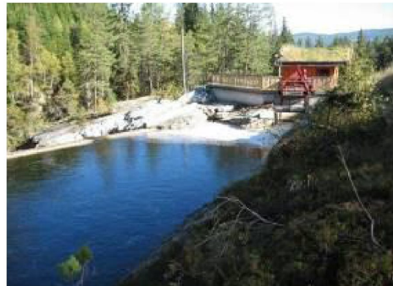
Bilde 15: Inntaksbasseng Nørståe I. Foto: Elvekraft
