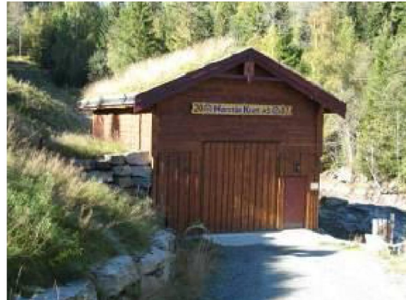
Bilde 13: Kraftstasjon Nørståe I. Foto: Elvekraft
