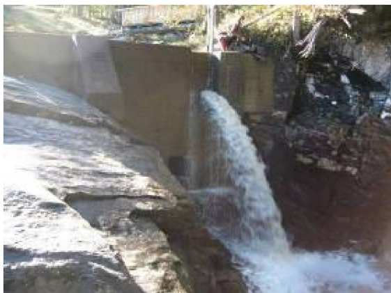
Bilde 16: Minstevannsslipp Nørståe I. Foto: Elvekraft
