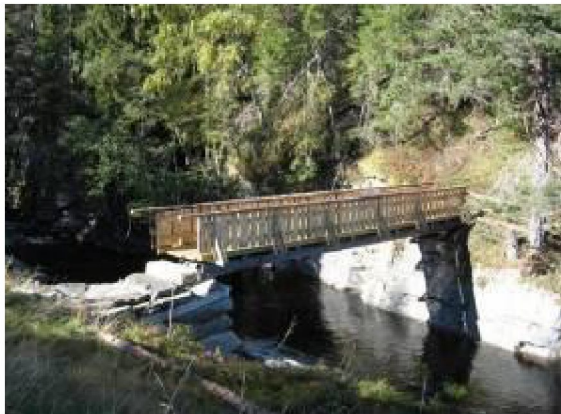
Bilde 14: Gangbru oppstrøms demning til Nørståe I. Foto: Elvekraft
