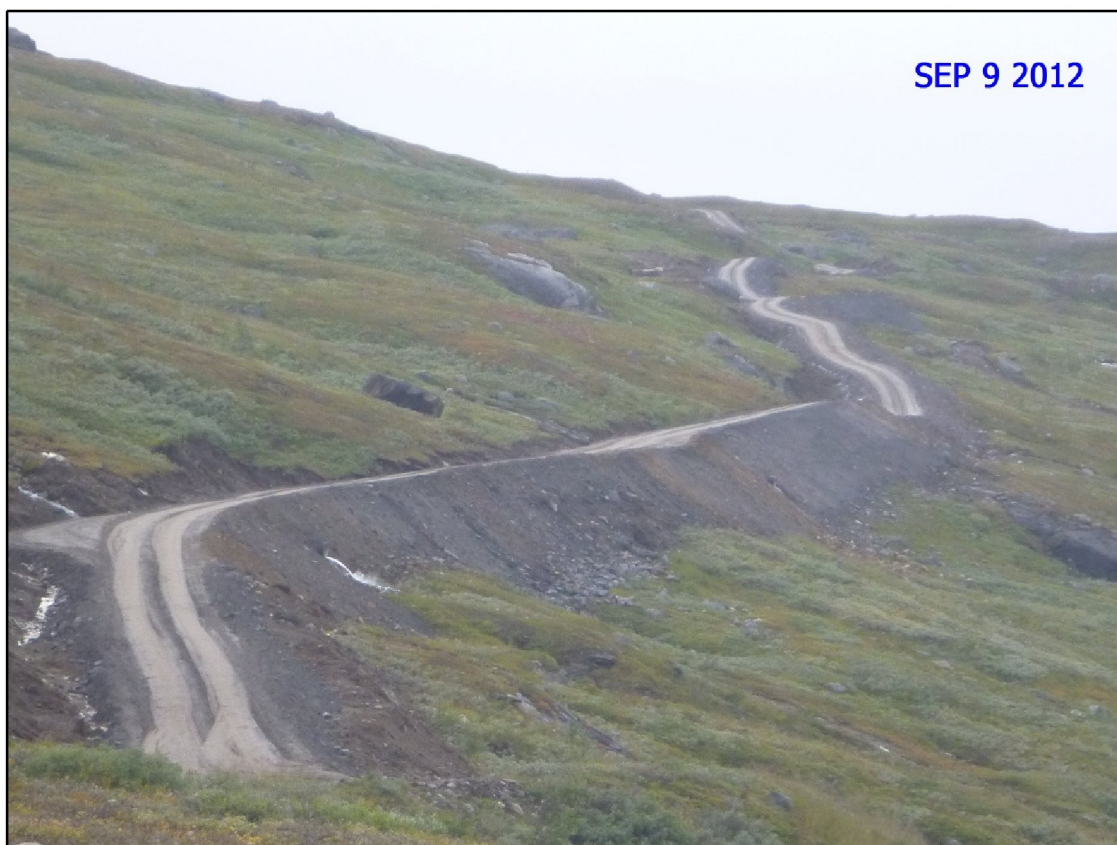
Statkrafts anleggsvei til eksisterende bekkeinntak
