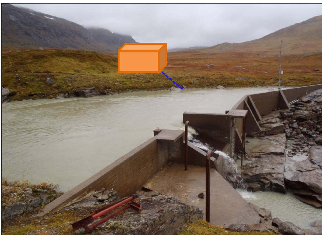
Plassering av kraftstasjon. Eksisterende dam og inntak tilhørende Statkraft vises i forgrunnen.
