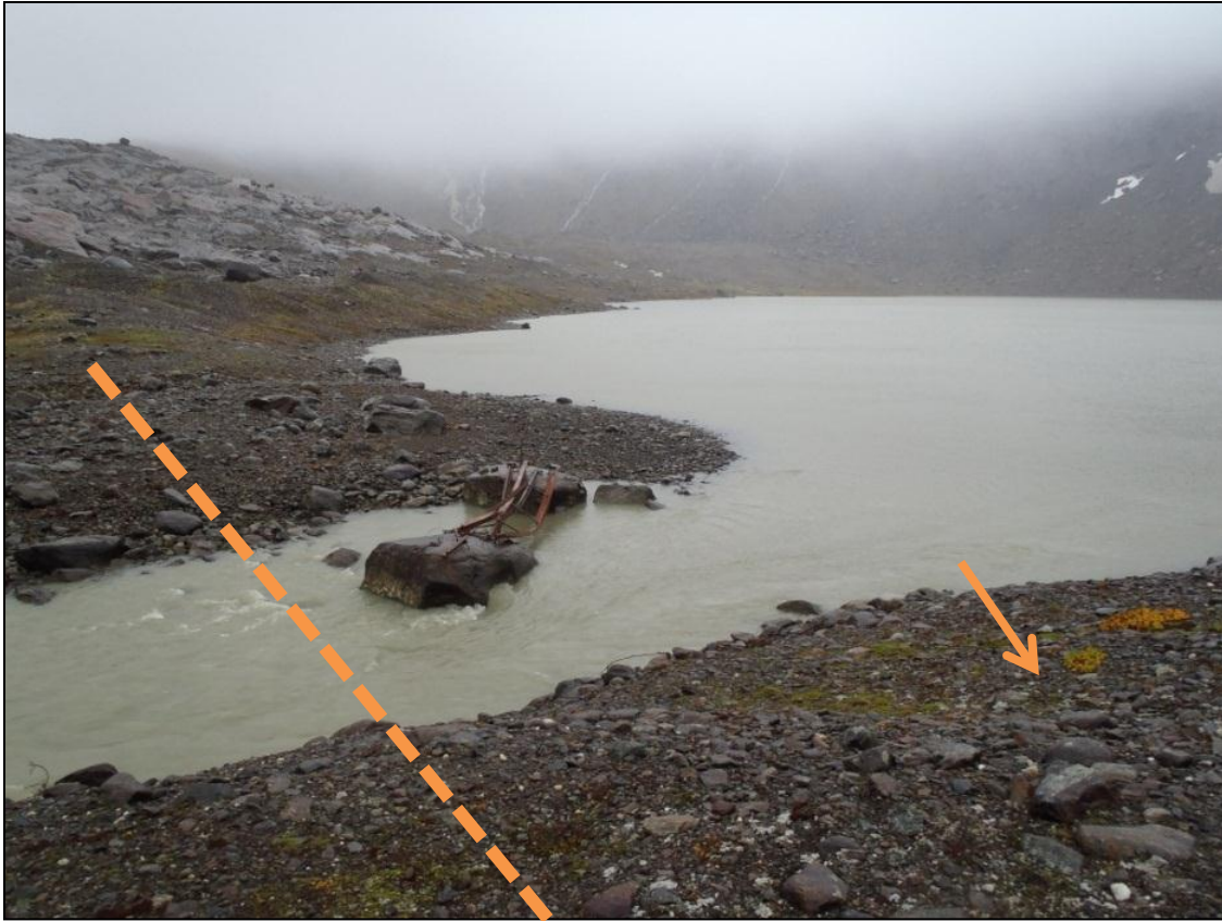
Figur 7. Plassering av dam (stiplet linje antyder damaksen) og inntak (pil)
