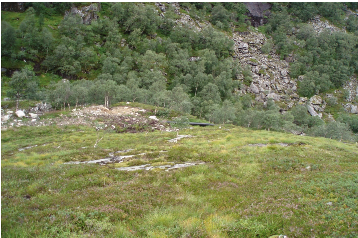
Eksempel på overdekking av rør i dagen ved naturlige overganger for dyr og evt sti ved Gjerde kraftverk
