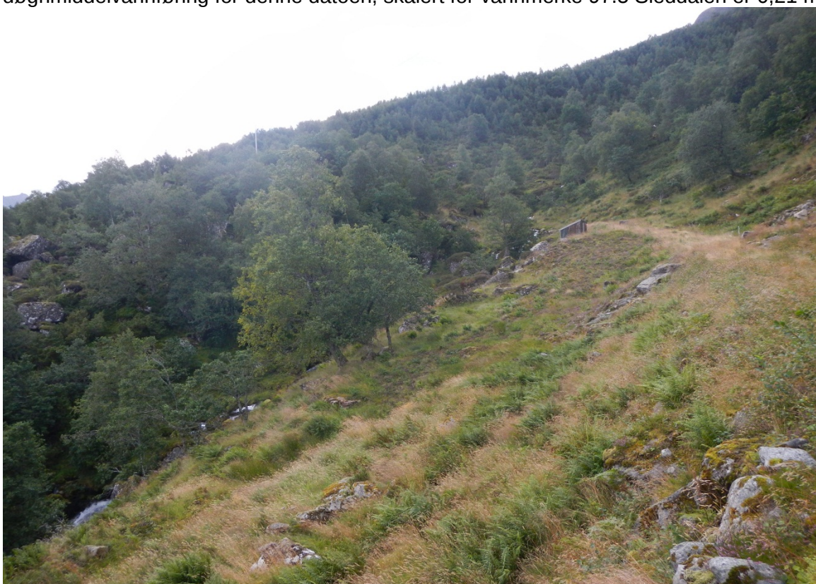
Bildet viser nedre del av elva med stasjonsområde nede til venstre, og riggområde ved eksisterende skogsveg. Bildet er tatt 29.08.2012
