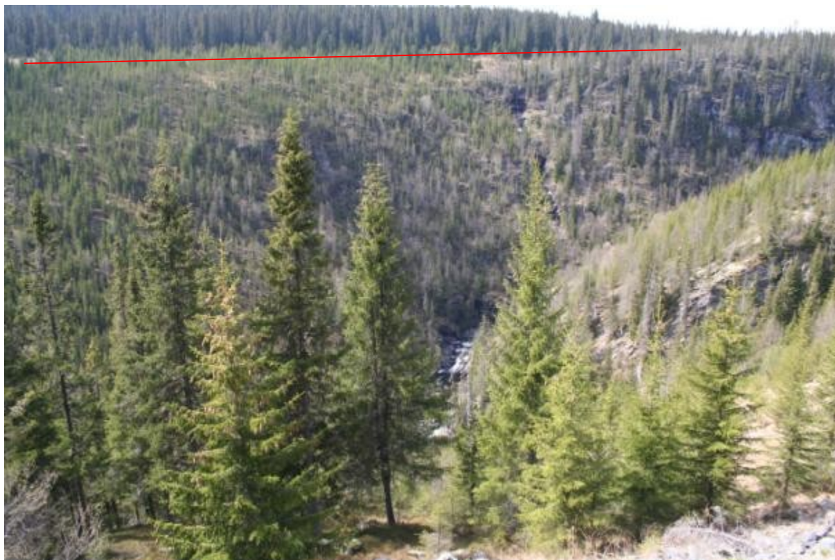
FIGUR 26: BILDET VISER RØRGATETRASE OG EKSISTERENDE SKOGBILVEI (RØD MARKERING) OG DELER AV VANNSTRENGEN. BILDET ER FRA MIDRE PARTI AV VASSDRAGET HVOR DET BLE TATT UT SKOG PÅ 1980-TALLET.
