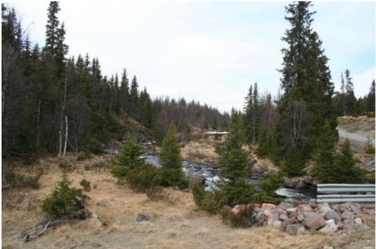
FIGUR 23. SETT OPPOVER VASSDRAGET FRA BROA SOM KRYSSER BENNA CA 200 M NEDSTRØMS INNTAKET.
