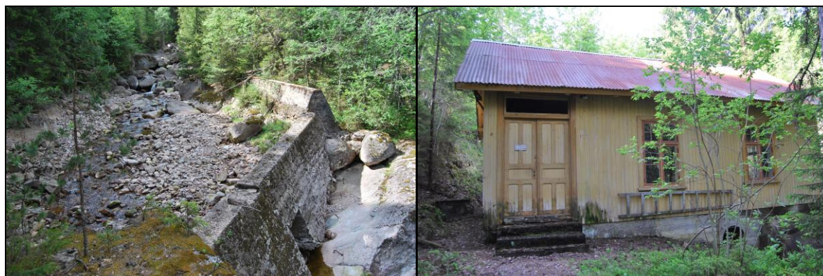
Figur 9. Restar av tidlegare kraftanlegg i Kvennåi: inntak og kraftstasjon.
