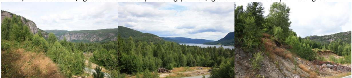
Nedre del av rørgatraseen før kryssing av fylkesveien.
