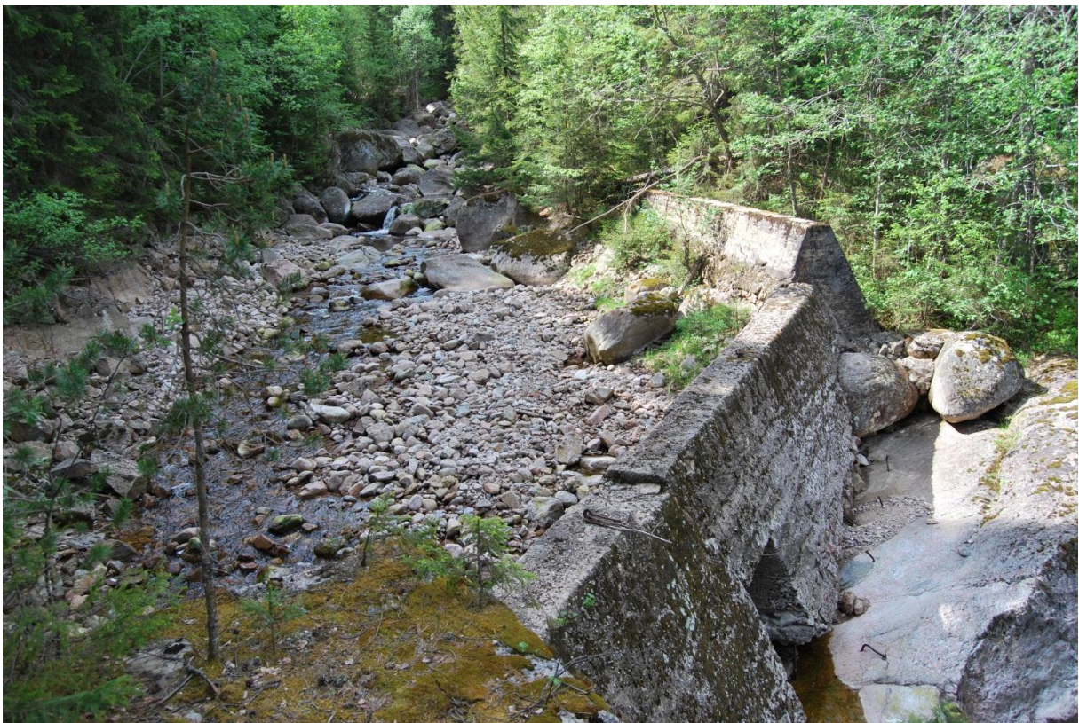
Figur 8. Tidlegare inntaksdam i Kvennåi. Den nye vassvegen vil krysse elva eit stykke oppstrøms denne.
