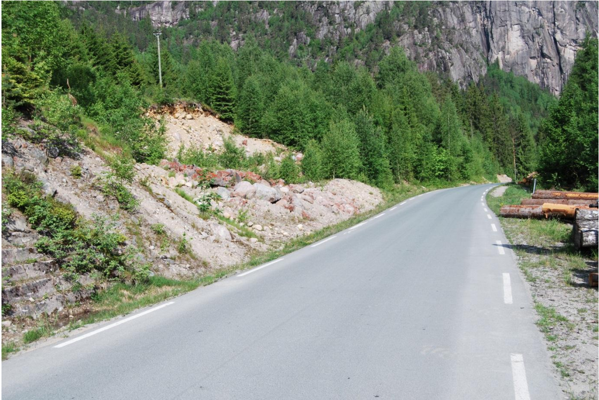
Figur 5. Område der vassvegen kryssar fylkesvegen.
