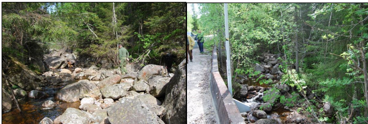
Figur 25. Venstre bilde viser område for inntak i Mjaugedalsåi, (inntak 1). Høgre bilde viser inntak i Fisktjønnbekken/bekken frå Nusstjørn, (inntak 2).
