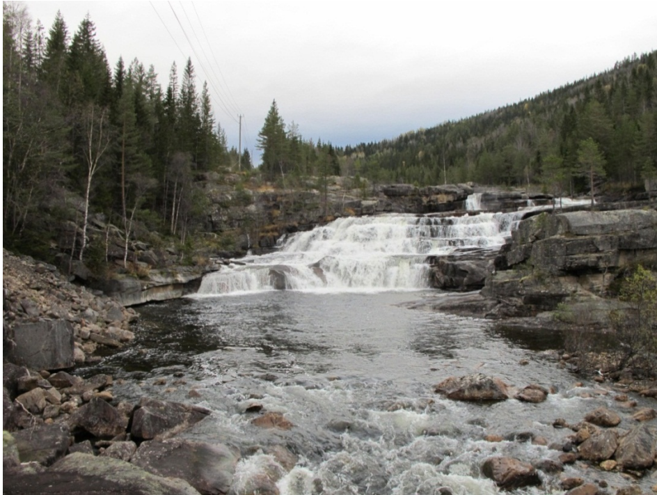
Kraftstasjonsplassering på venstre side
