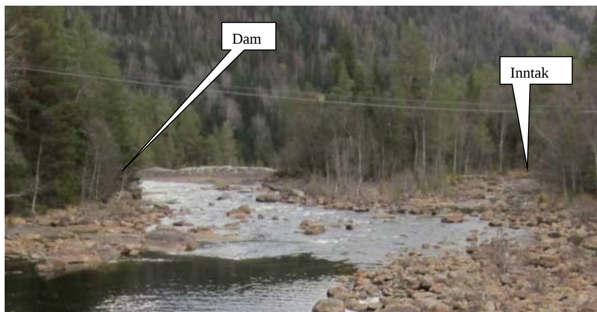
Figur 2.4 Dam og inntak blir ikke synlig, men vannspeilet heves i området på bildet som er tatt fra Gauset bru.
