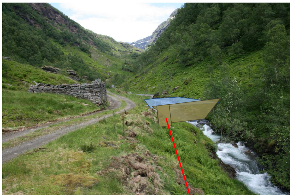
Fig. 14 Dam og inntak i Bjørndalen
