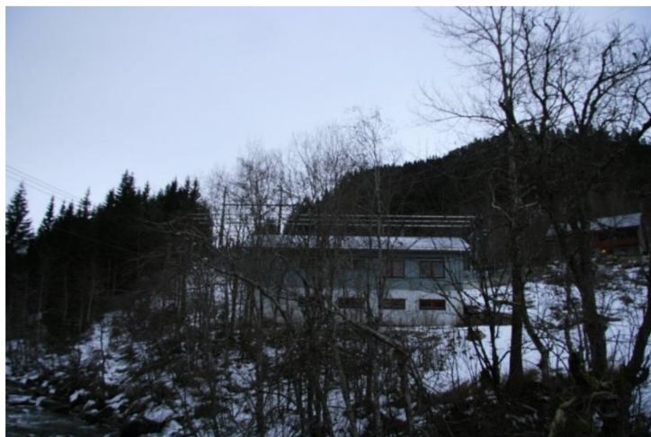
Figur 1 Eksisterende Trafostasjon ca. 313 moh
